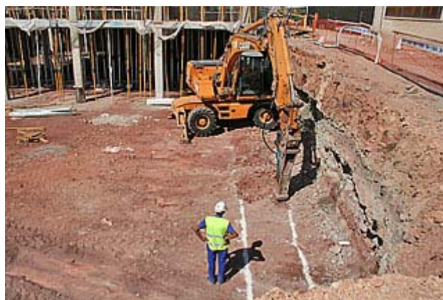
Excavación de zapatas.
