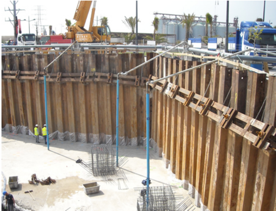
Arriostamiento por anclajes.
