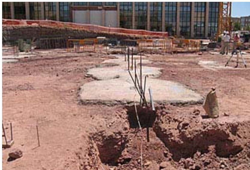
Proceso de hormigonado de
