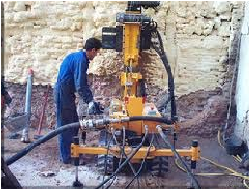
Perforación micropilote..
