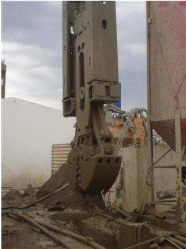
Excavación con cuchar bivalva.
