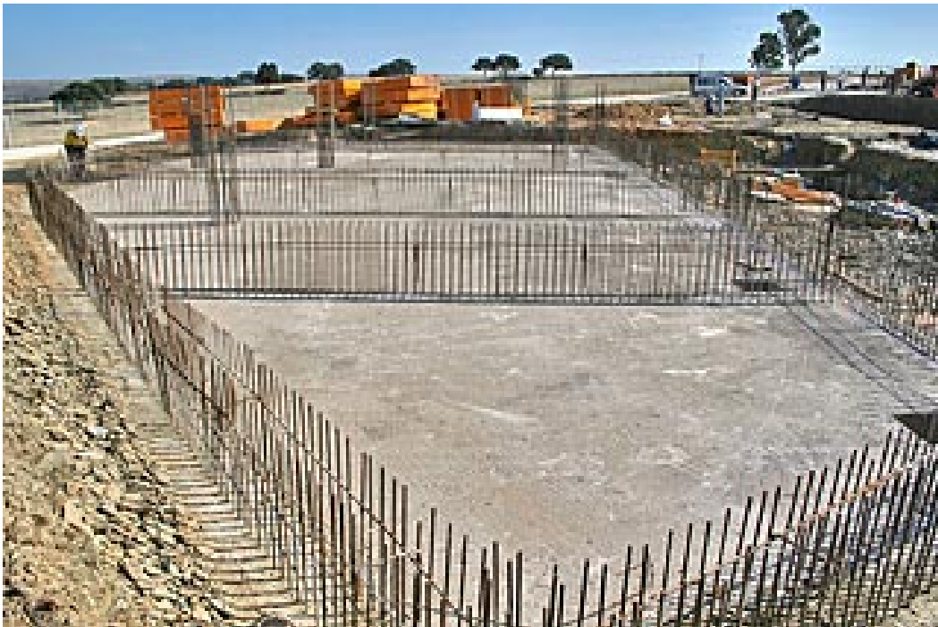
Armaduras de espera.
