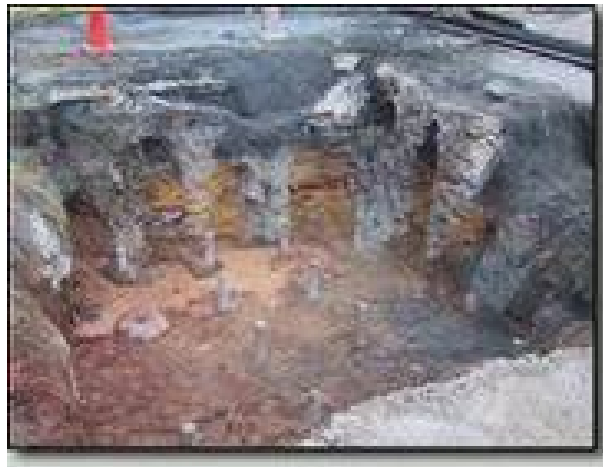
Trabajos de jet grouting..
