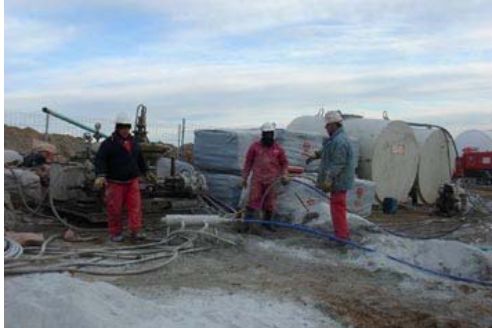
Proceso de inyección.
