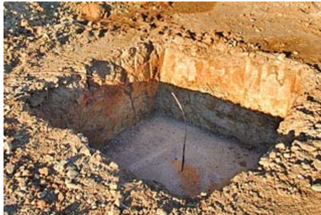
Excavación y eje de zapata.
