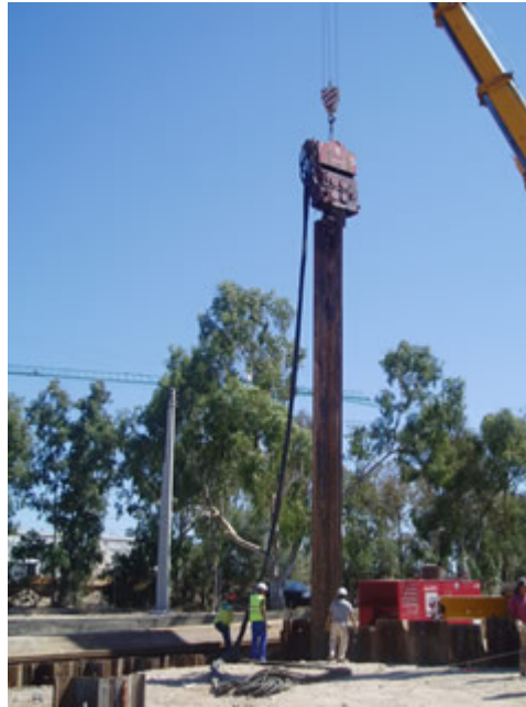
Hinca de tablestaca.
