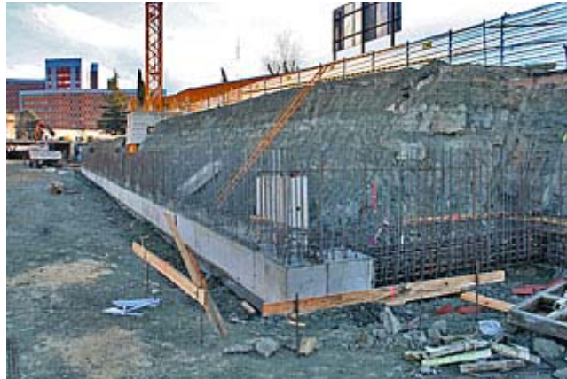
Viga de coronación.
