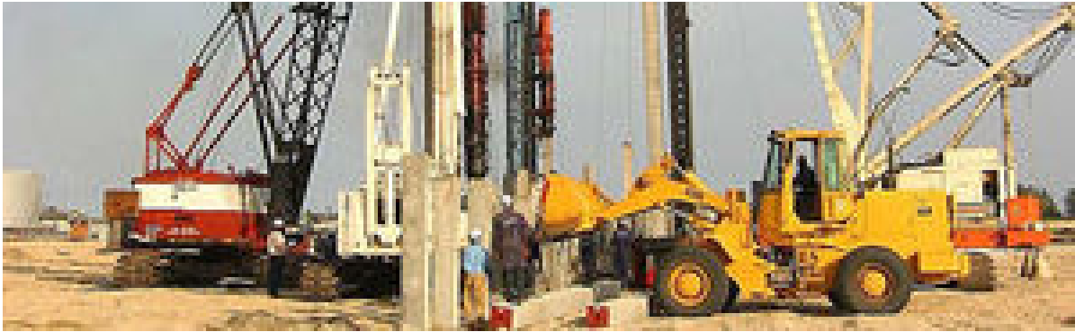
Maquinaria para ejecución pilotes.
