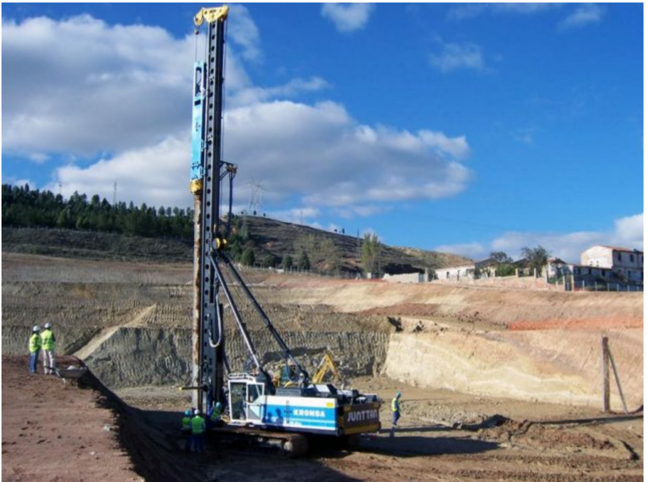
Trabajos de hincado de pilotes.
