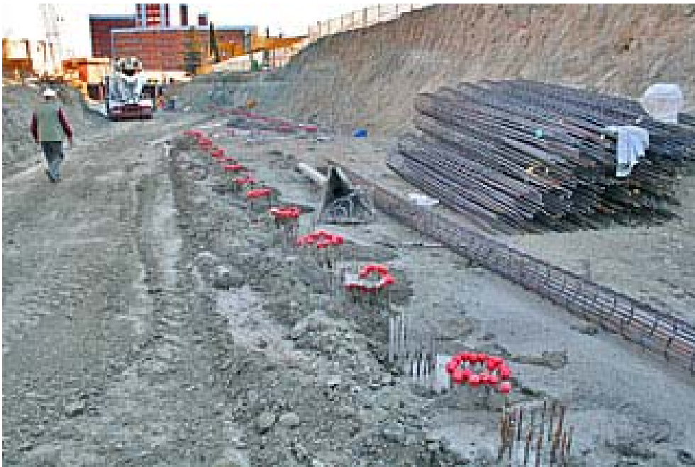
Pilotes y armaduras.
