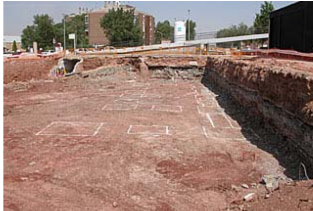
Replanteo zapatas aisladas.
