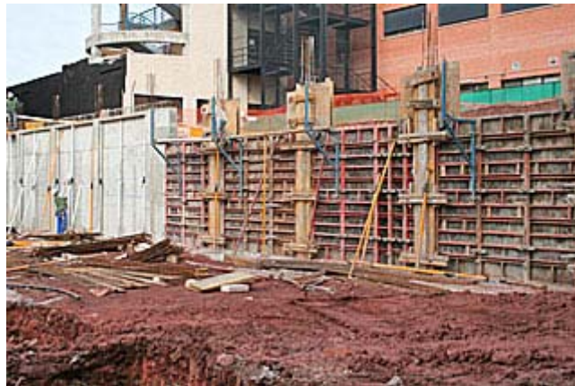
Muro preparado para hormigonar.
