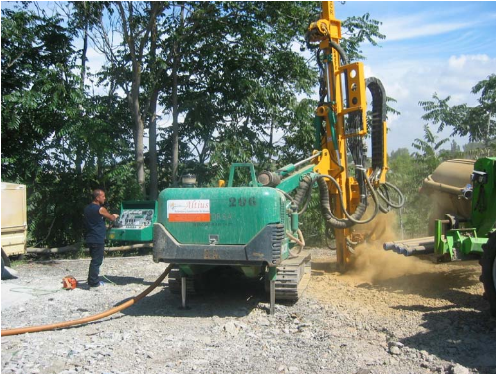
Procedimientos de inyección.
