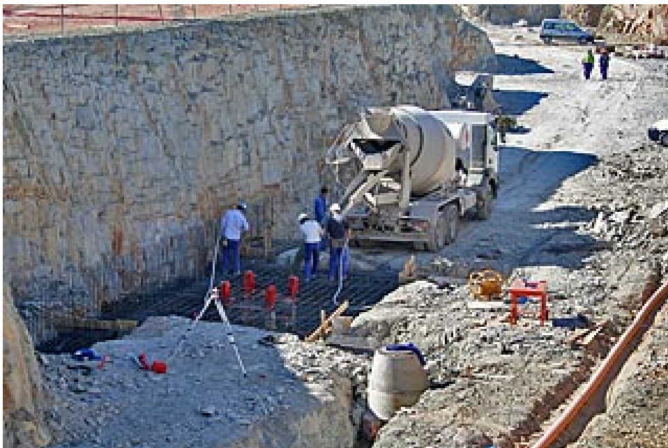
Hormigonado zapata.
