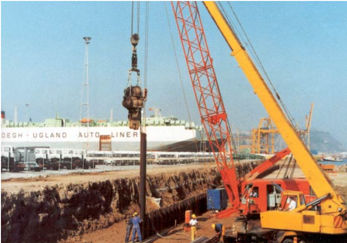
Hincado de tablestacas.
