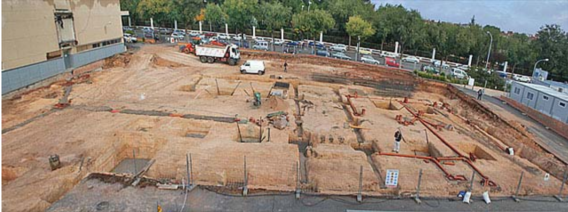
Vista general de zapatas aisladas.
