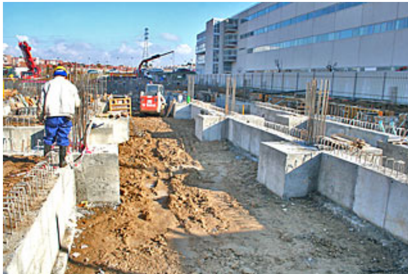
Zapatas y vigas hormigonadas y desencofradas.
