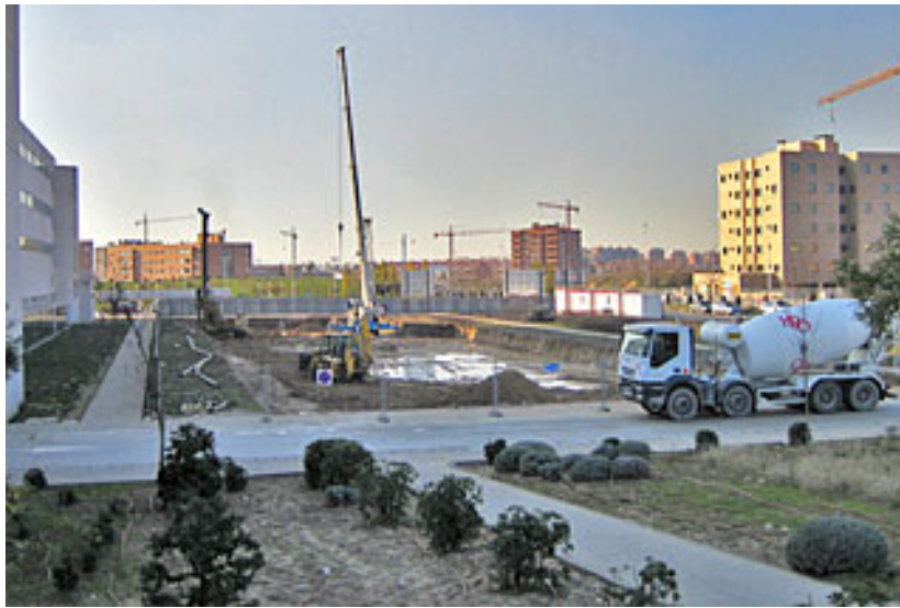
Vista general trabajos de pilotaje.
