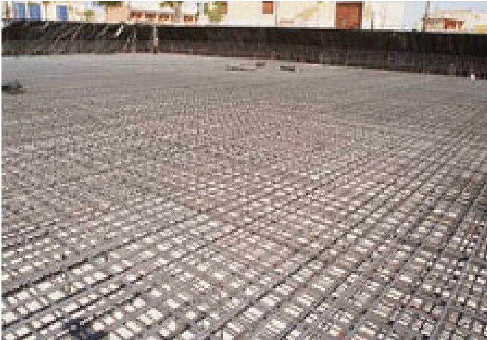
Losa de cimentación.
