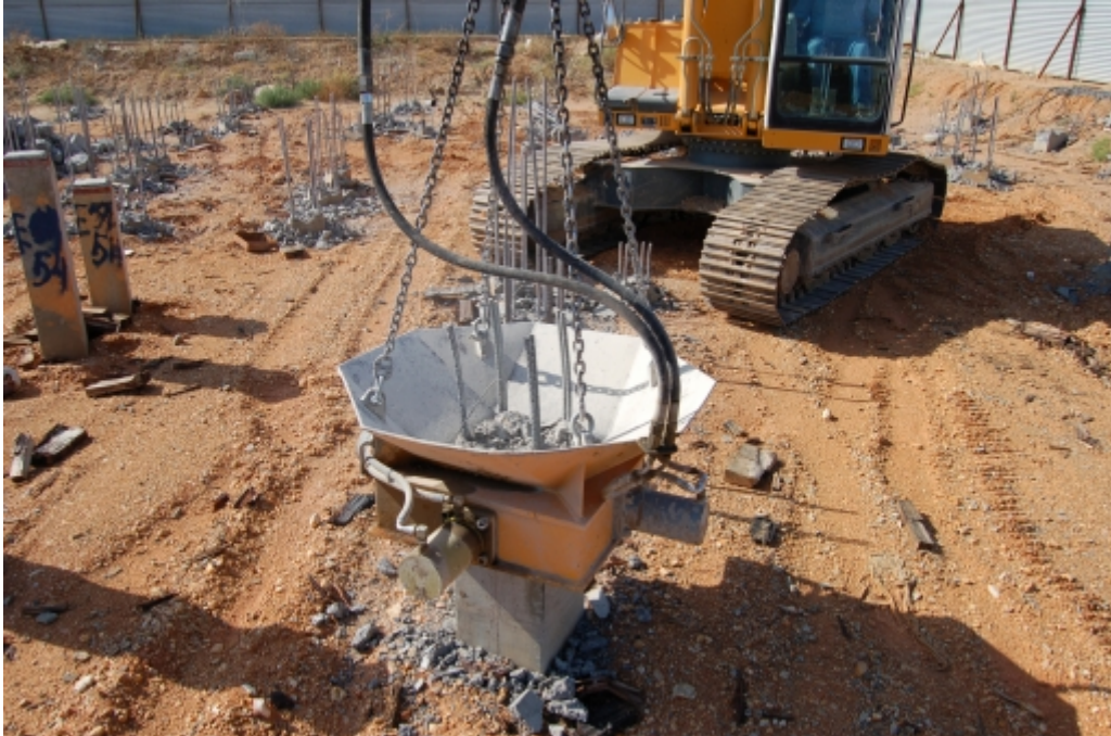
Demolición cabezas de pilotes.
