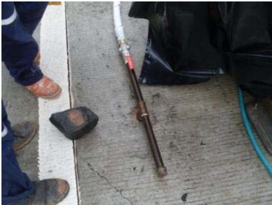
Inyección de la lechada.
