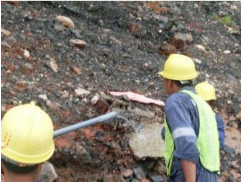
Marcado puntos de inyección.
