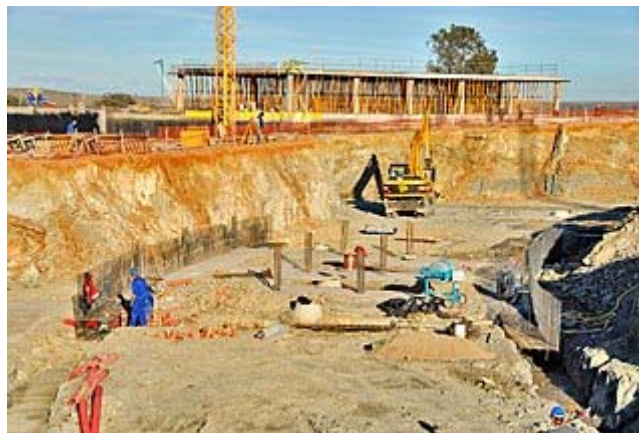
Trabajos en zapatas corridas.
