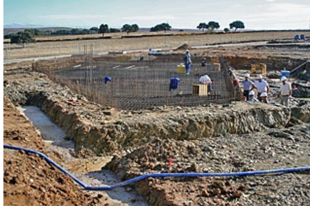
Trabajos en losa.
