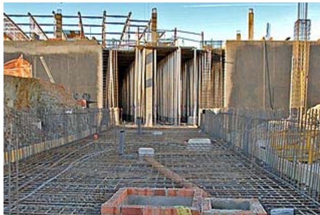
Losa de cimentación.
