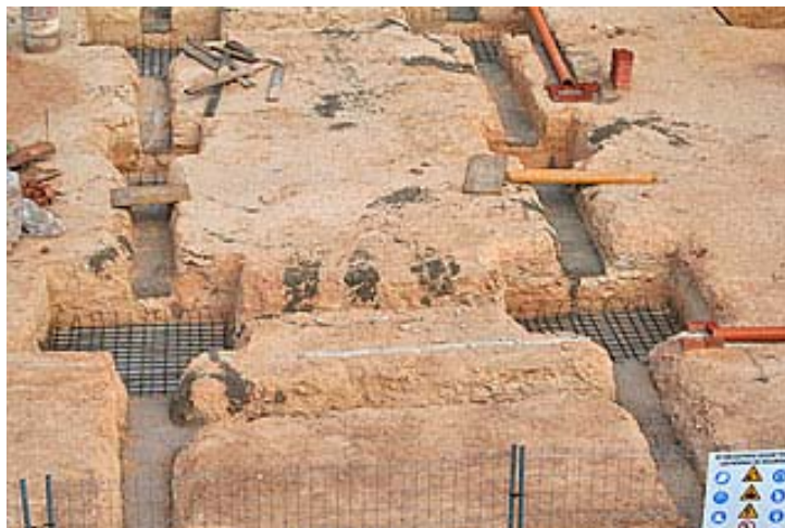
Limpieza y armadura inferior.
