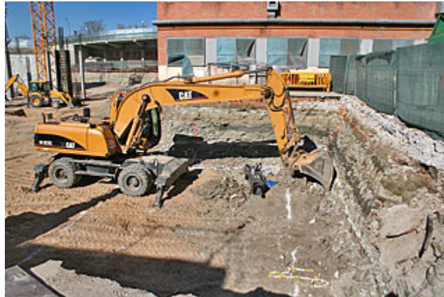
Excavación de muro.
