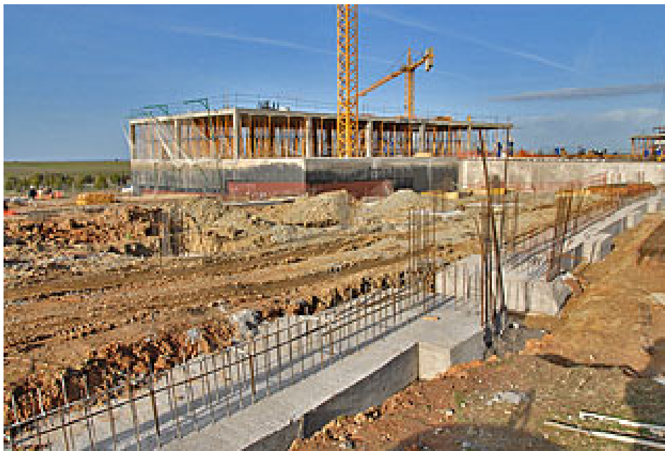
Vista de zapatas ejecutadas.
