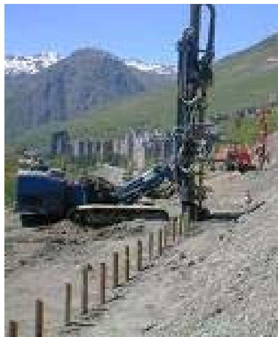
Ejecución de micropilotes.
