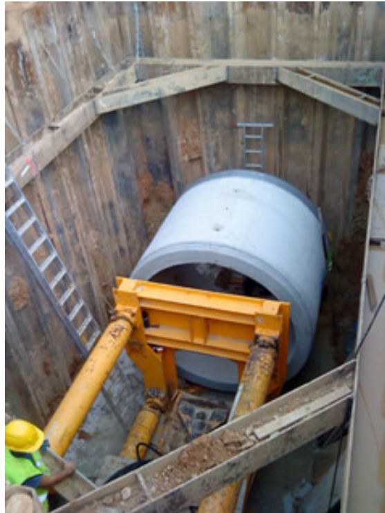
Arriostamiento por vigas y codales.
