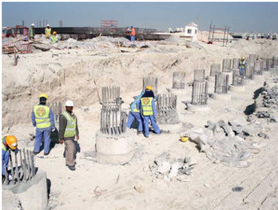
Vista de plataforma de trabajo.
