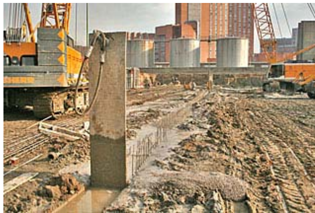
Trabajos en muro pantalla.
