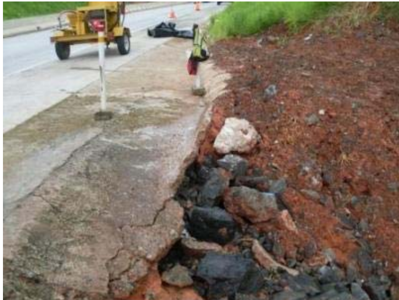
Distancia entre perforaciones.
