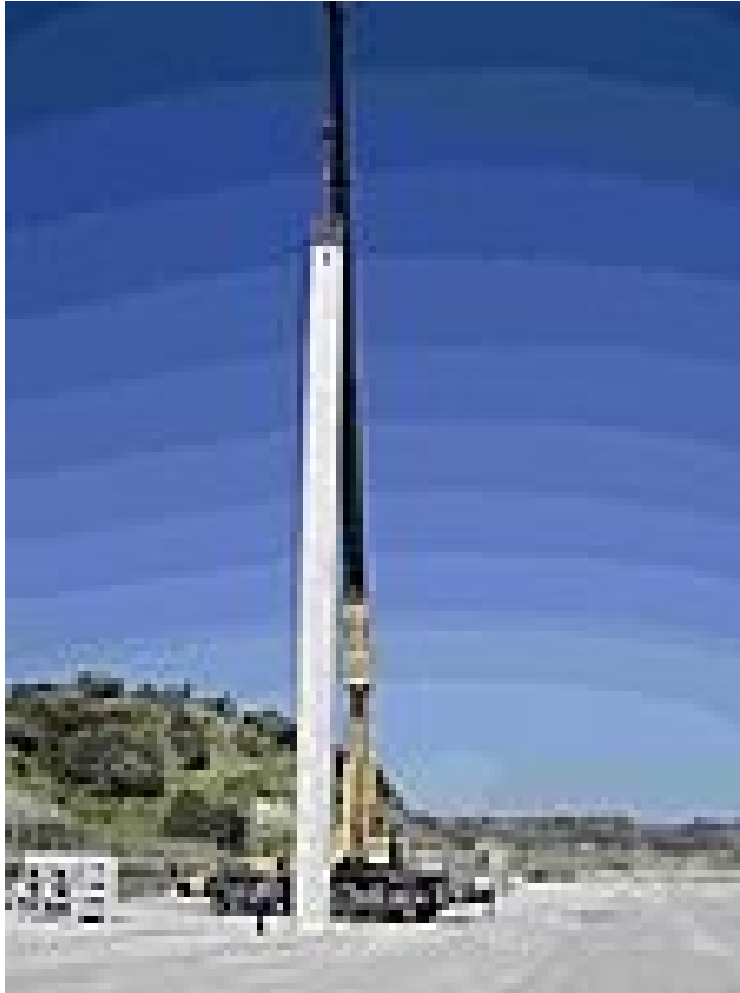
Hincado de pilote.
