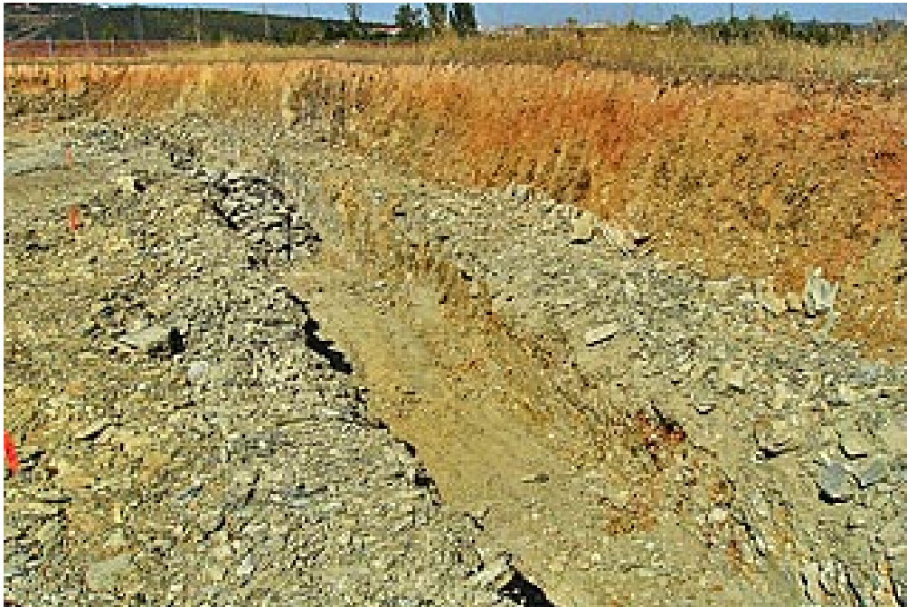
Ejecución de zapatas.
