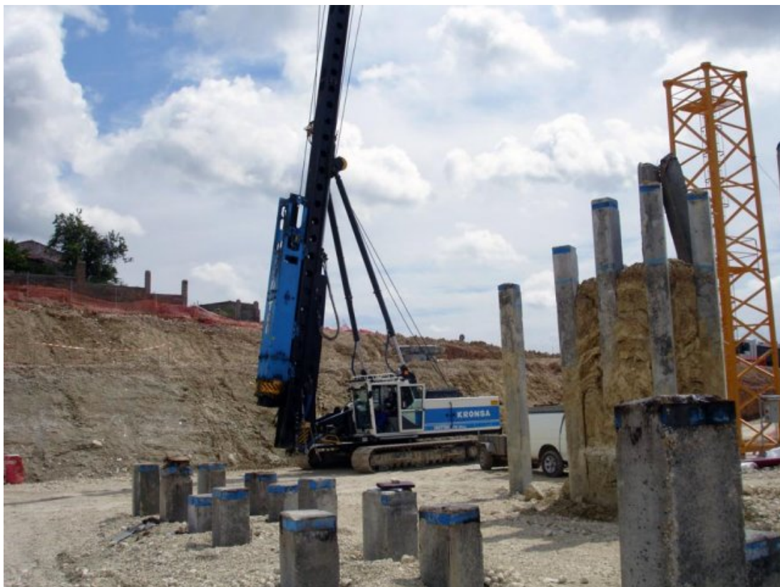
Hinca de pilotes.
