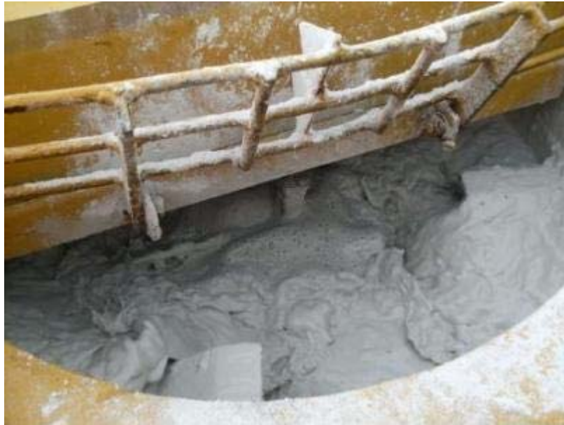
Mezclado de la lechada.
