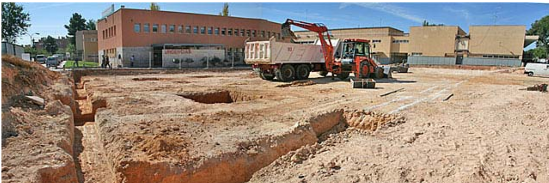
Excavación en zapatas y vigas de atado.
