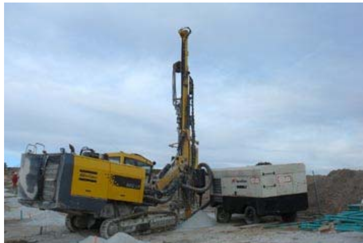
Maquinaria de inyección.
