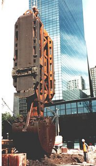
Procedimiento de excavación entre muretes guía.
