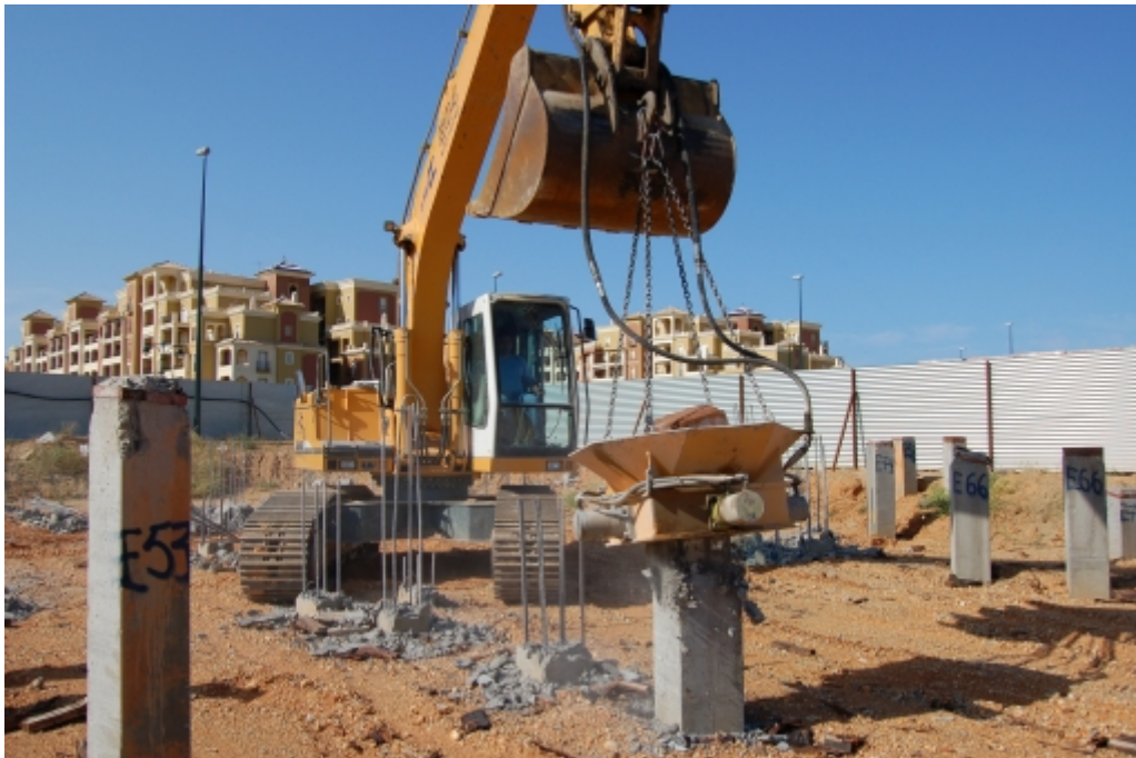
Marcado de pilotes.
