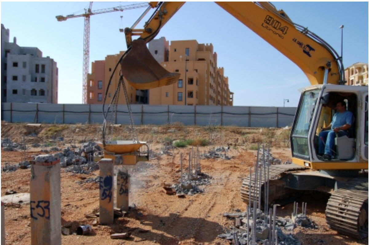
Descabezado de pilotes.
