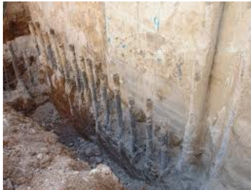
Armadura micropilote.
