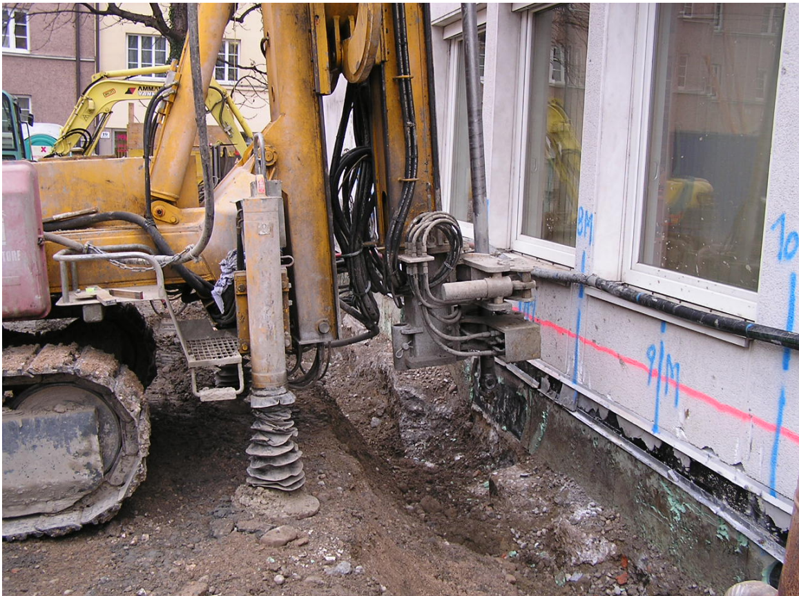
Marcado de trabajos.
