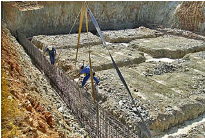
Colocación de armado en zapatas corridas.
