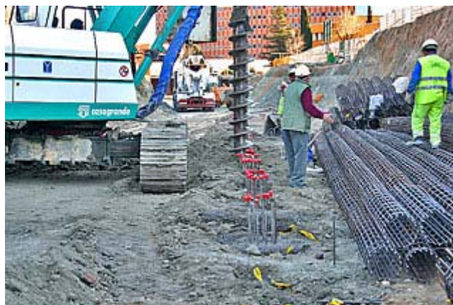
Perforación y armaduras.
