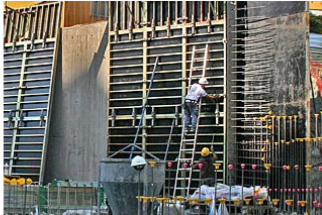
Desenfofrado de muros.
