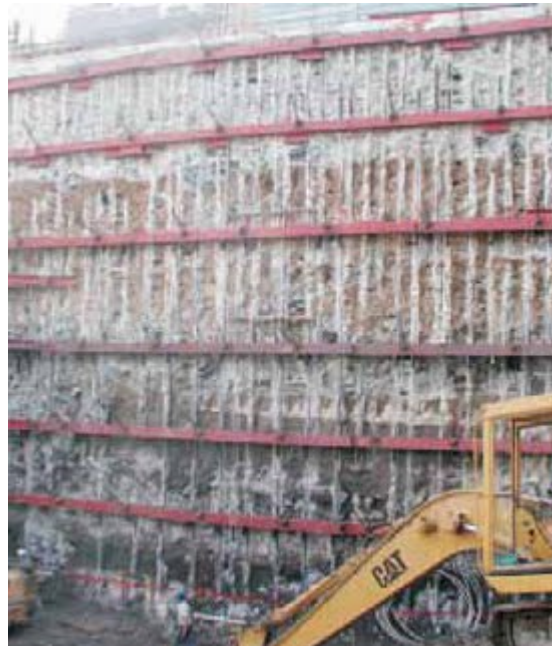
Inyección en micropilotaje.
