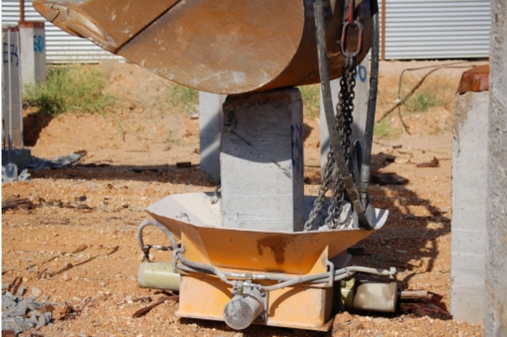
Demolición cabezas de pilotes.
