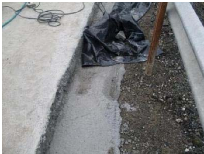
Sellado para evitar pérdidas.
