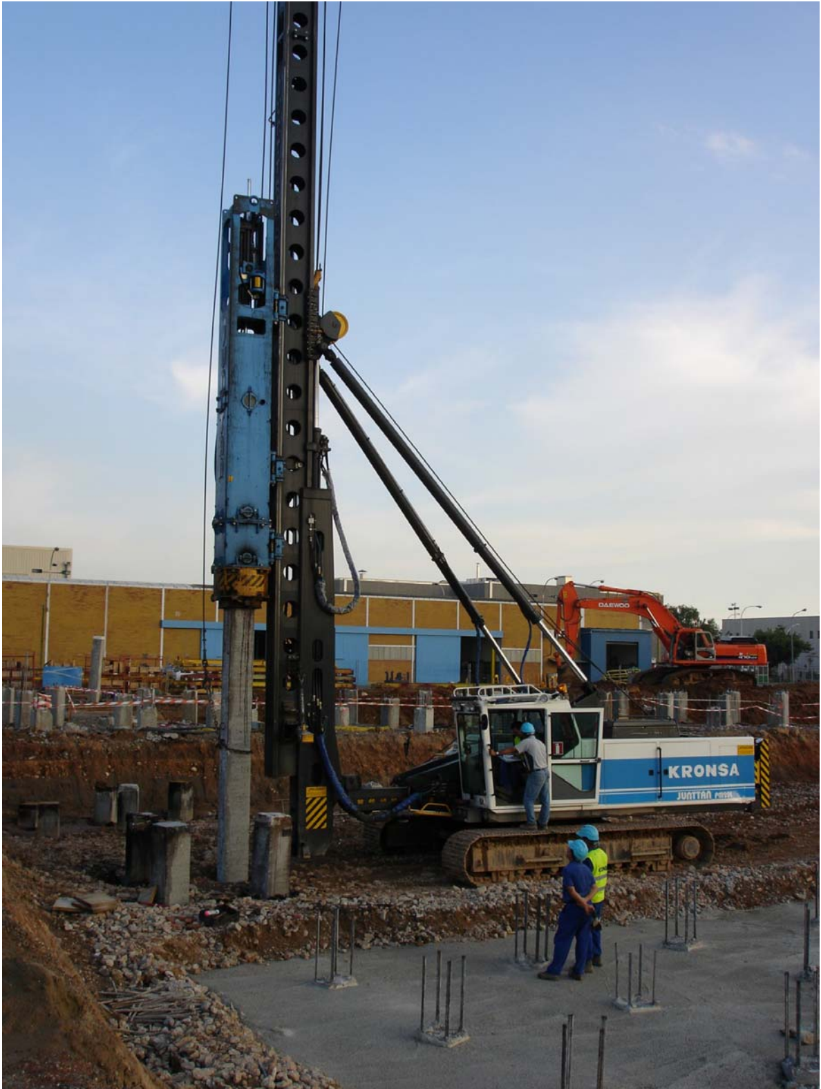
Hincado de pilotes.
