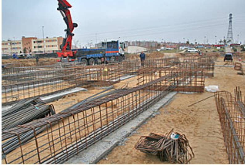
Ferrallado de zapatas y vigas de atado.
