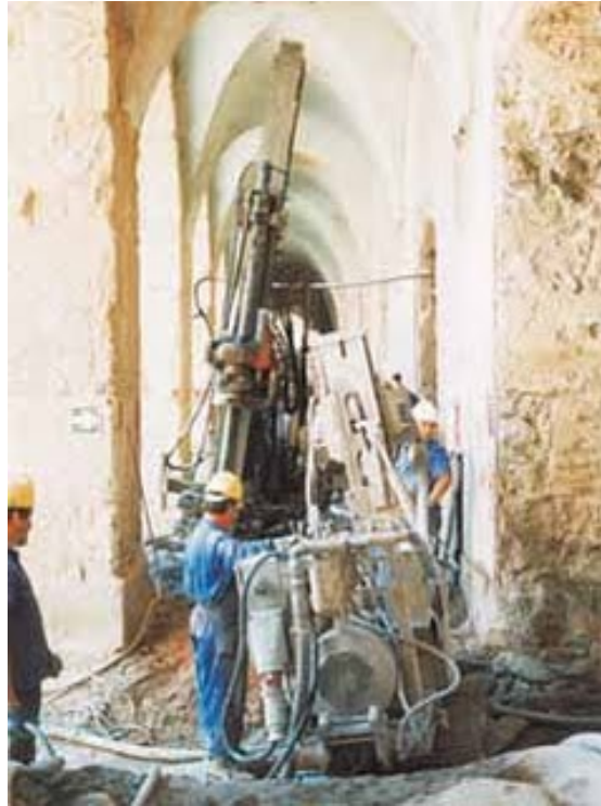
Inyección por jet grouting..
