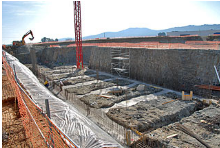
Protección taludes excavación.
