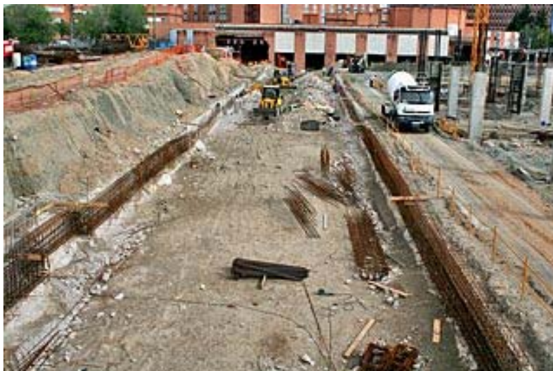
Unión superior viga de atado muros pantalla.
