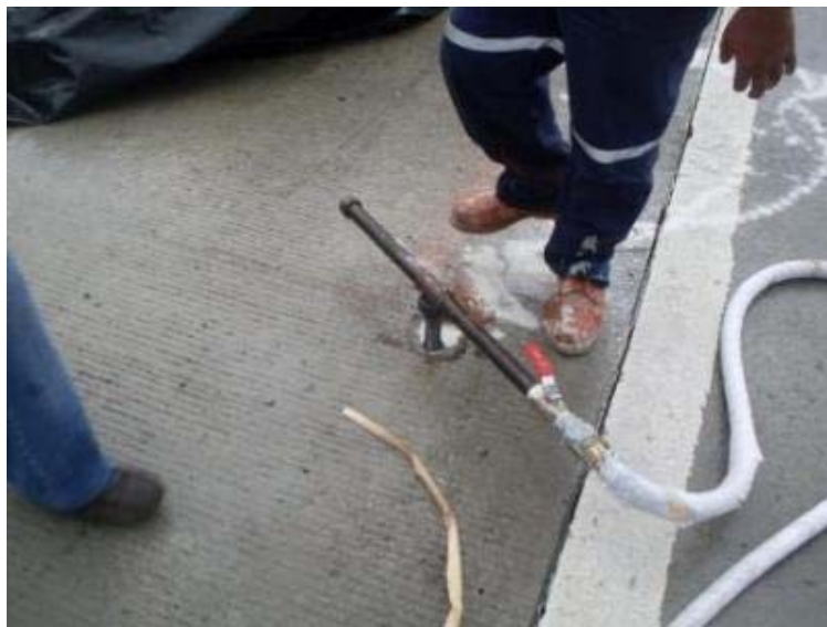
Proceso de inyección.
