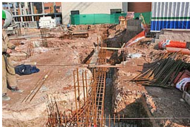
Armado zapatas y vigas.
