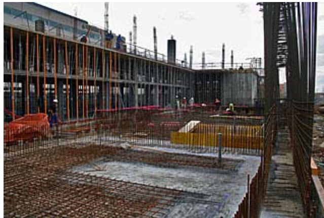
Hormigonado losa por fases.
