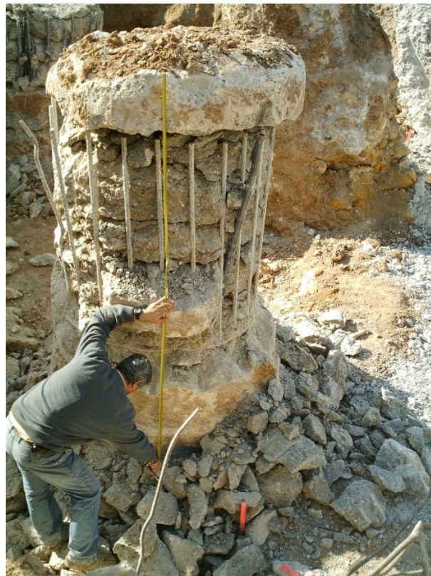
Comprobando longitud esperas.
