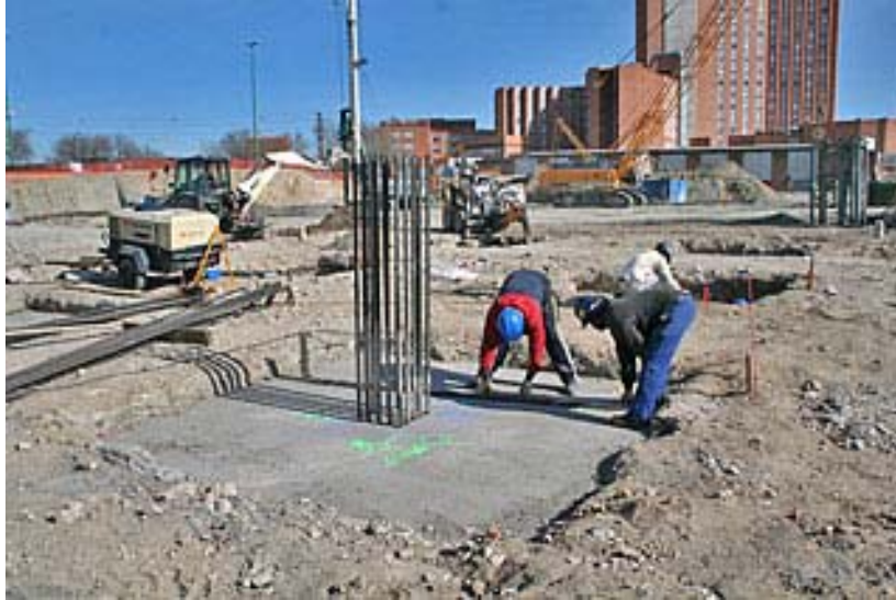
Comprobación en zapatas.
