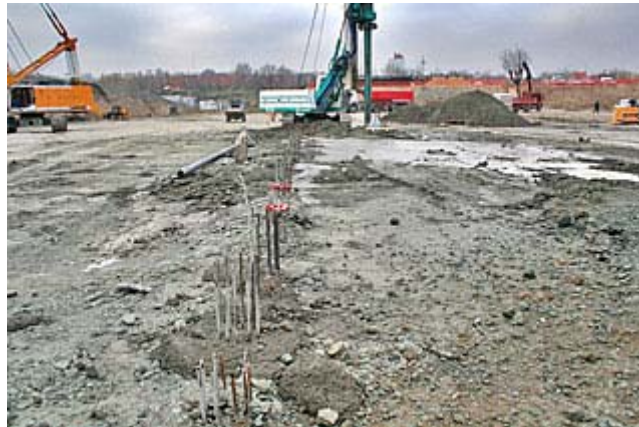
Pilotes in situ.
