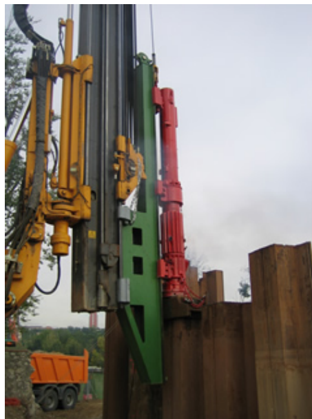
Golpeo de tablestacas.
