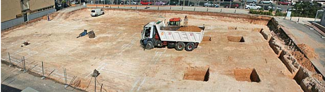
Zapatas excavadas.
