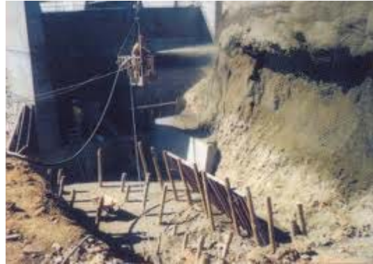
Armaduras para encepados.
