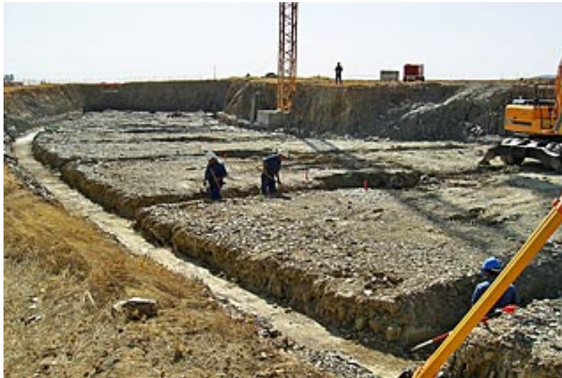
Comprobaciones de la excavación.
