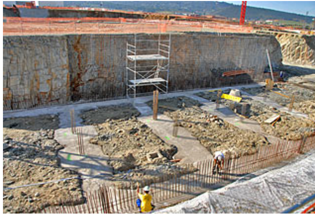
Hormigonado en zapatas corridas.
