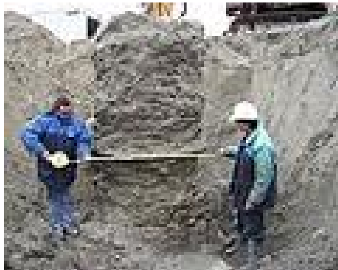
Comprobación de columna.
