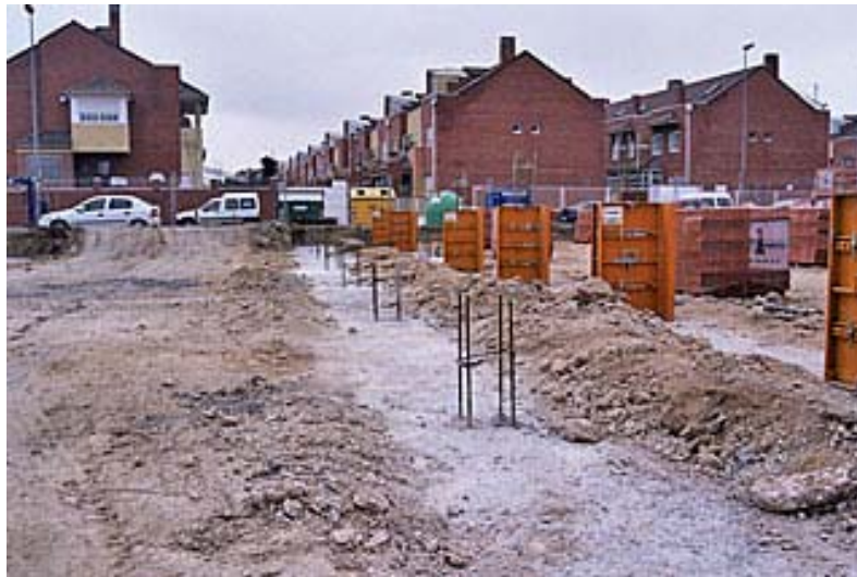
Zapatas corridas ejecutadas.
