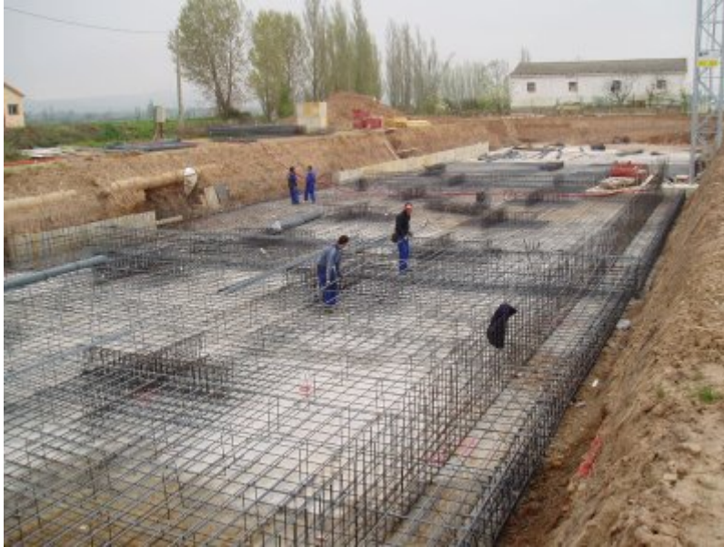
Distintas fases en la ejecución de una losa.
