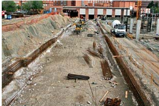
Armaduras colocadas.
