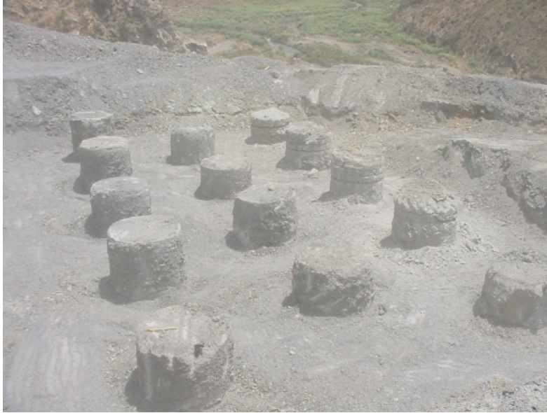
Pilotes in situ.
