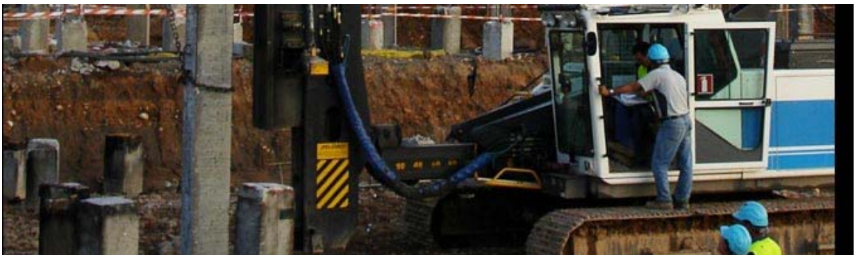
Trabajos de pilotaje.
