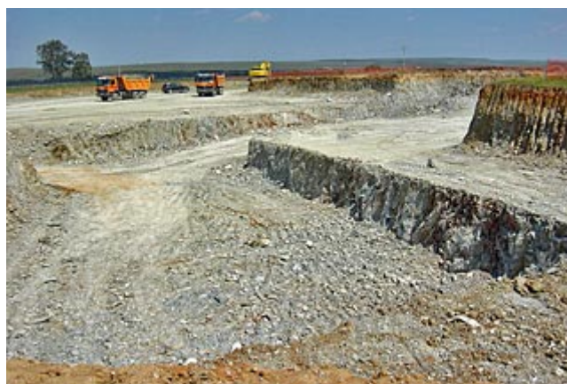
Excavación para losa.
