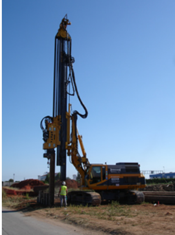
Procedimiento de hincada. Vibración.
