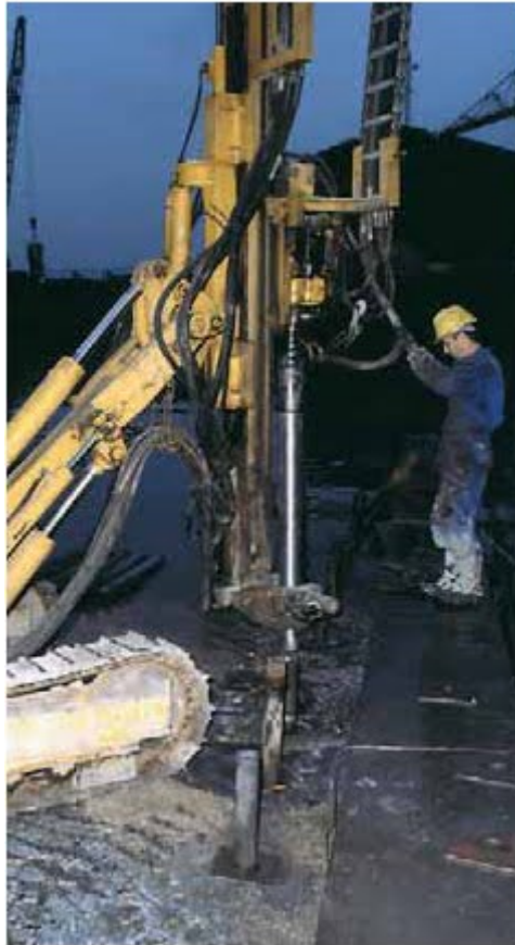
Perforación de micropilotes..
