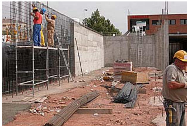
Trabajos de ferrallado en muro.
