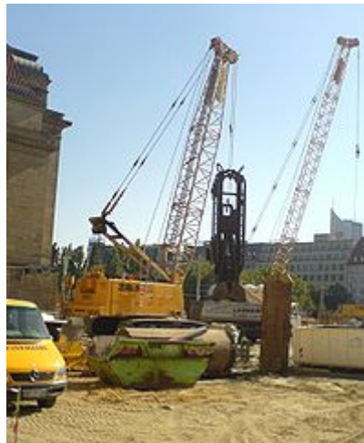
Ejecución de bataches.
