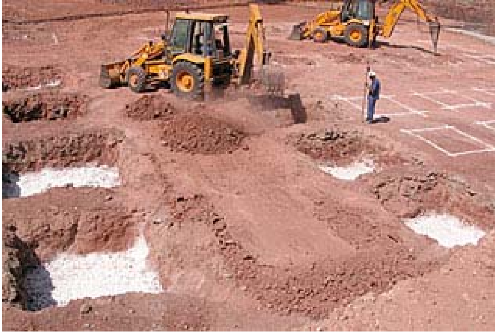
Replanteo y excavación.
