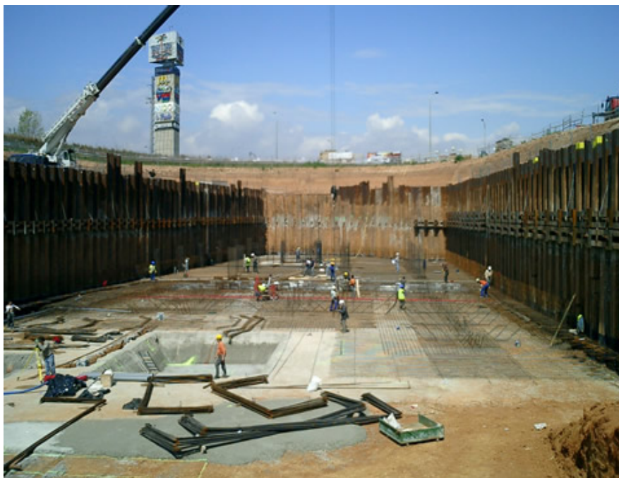
Vista general trabajo con tablestacas.
