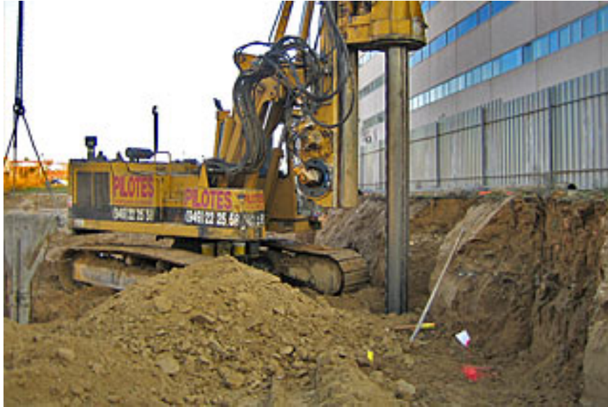
Perforación para pilote.
