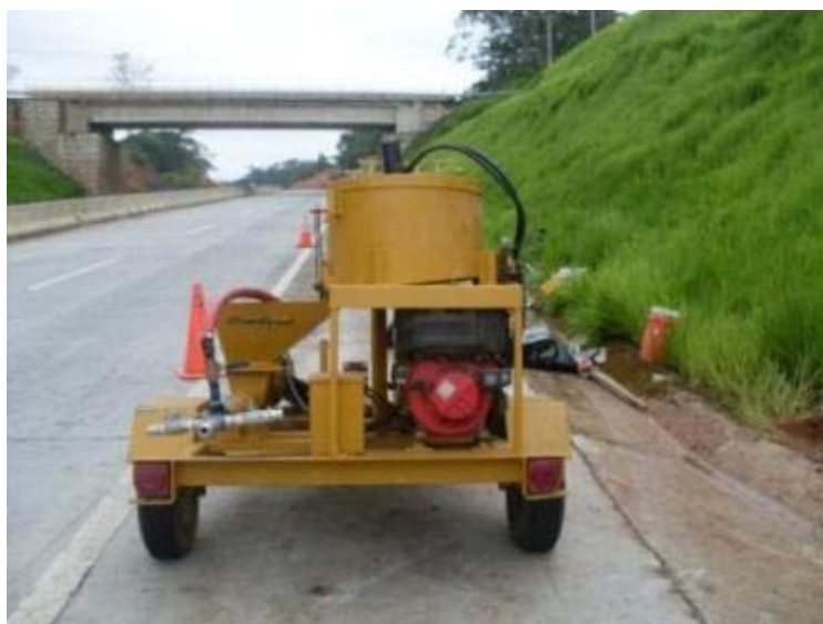
Maquinaria preparación lechada.
