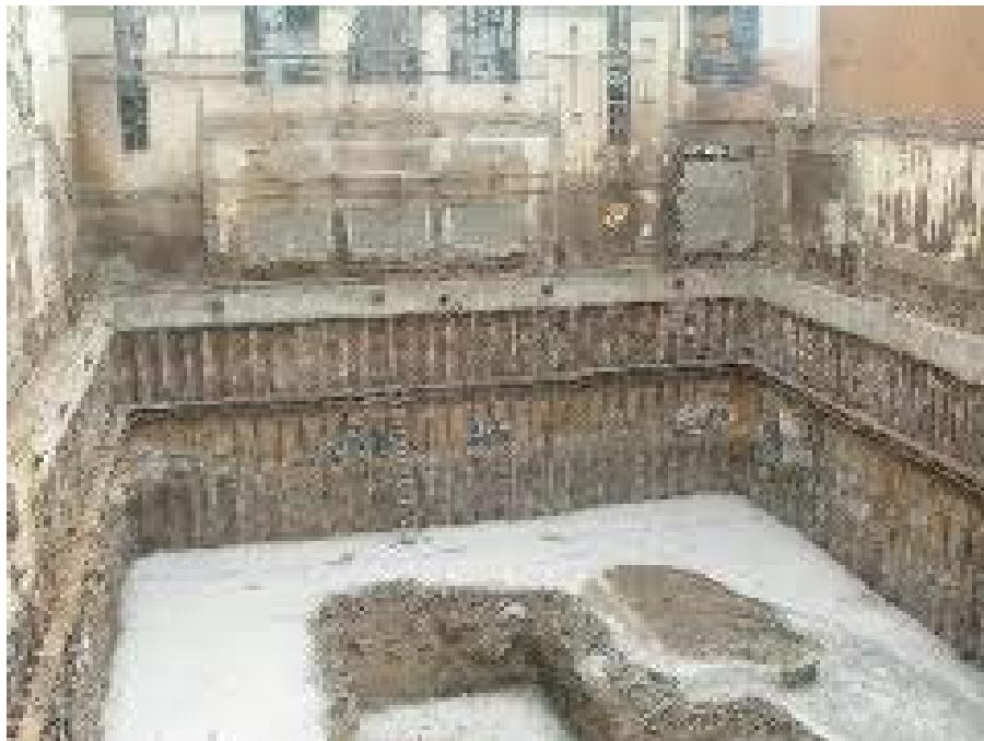
Cimentación por micropilotes..
