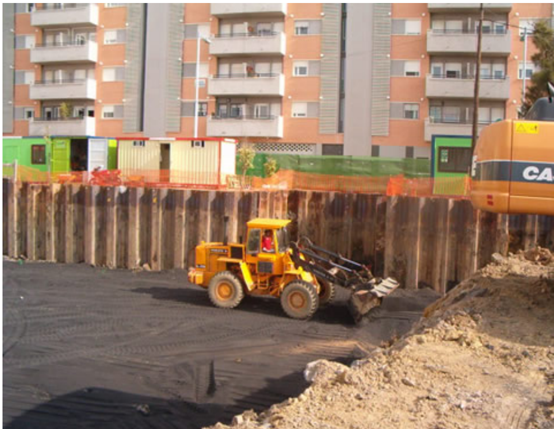
Excavación en pantalla de tablestacas.
