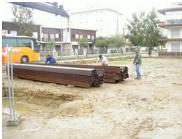
Manipulación de tablestacas.
