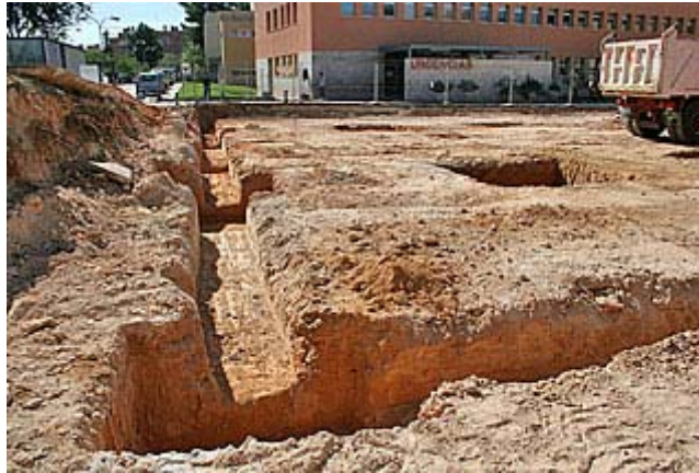
Excavación en zapatas.
