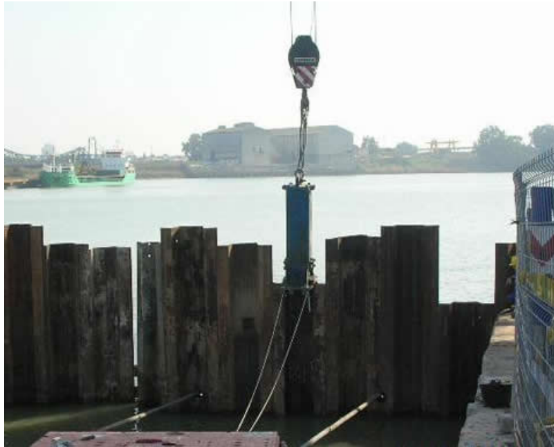
Trabajos con tablestacas.
