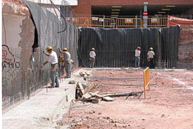
Impermeabilización del trasdós
