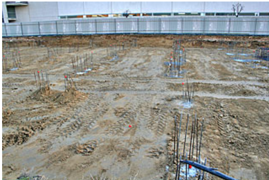
Armaduras de espera pilotes.
