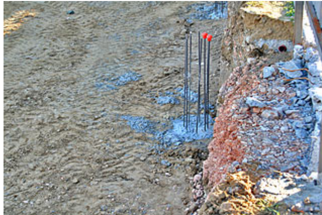
Pilote ya hormigonado.
