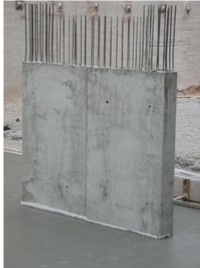
Muro de hormigón.
