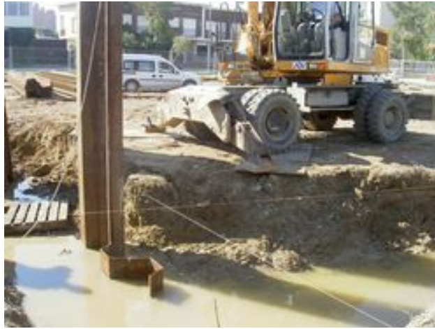
Hinca de tablestacas.
