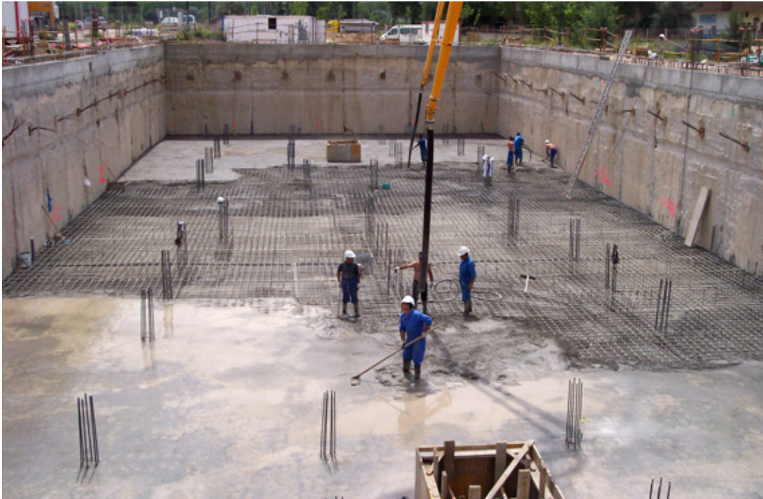
Hormigonado de losa.
