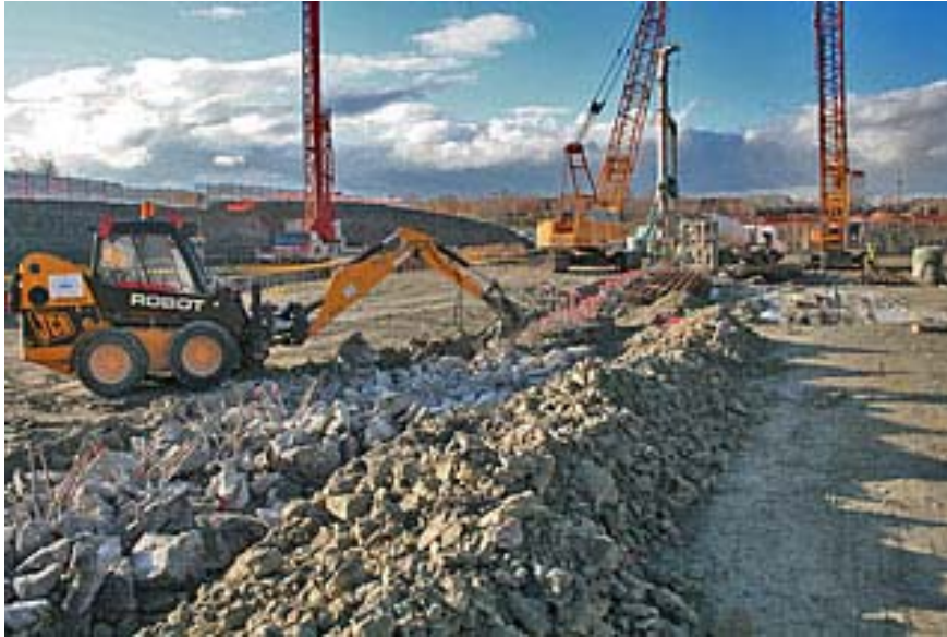
Picado de cabezas para el encepado.
