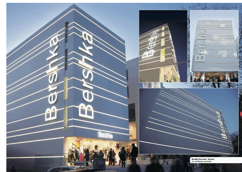
MATERIALIDAD - EDIFICIO TIENDA BERSHKA
