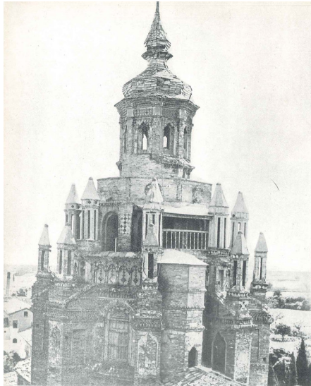
Catedral de Tarazona (Zaragoza). El cimborio, antes de su restauración
