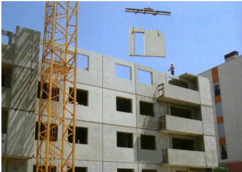
Ilustración 17: Instalación módulos BSCP
