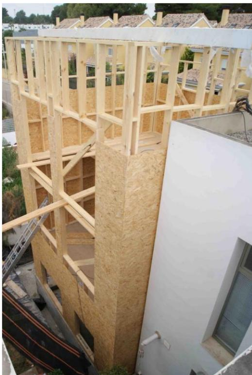
Ilustración 8 Estructura de madera (Modular Projects)
