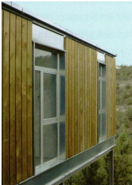
Ilustración 3: Acabados exteriores de madera (Sistema Cuatro50)
