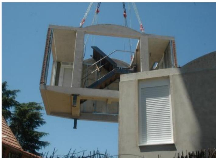
Ilustración 15: Módulo completo con escalera (Sistema OBOX)
