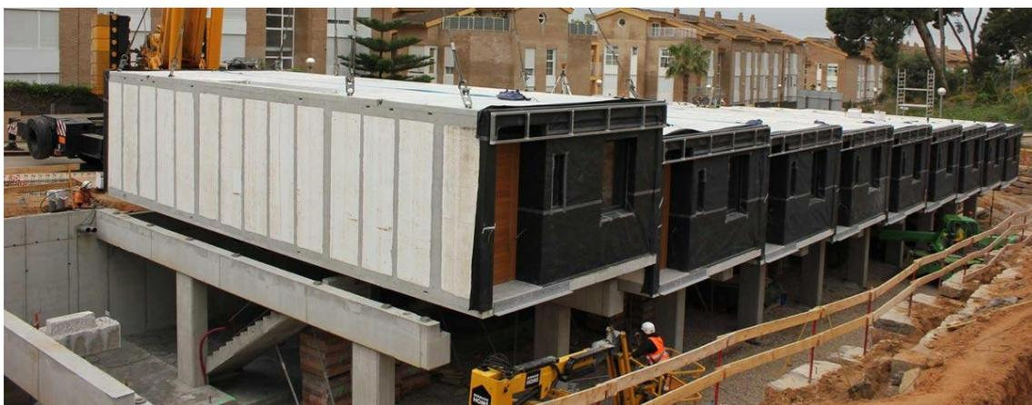
Ilustración 16: Instalación módulos COMPACTHABIT
