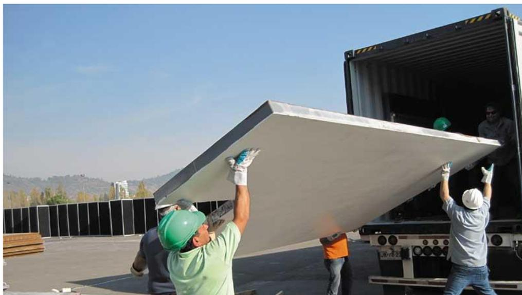
Ilustración 13: Transporte paneles Baukit
