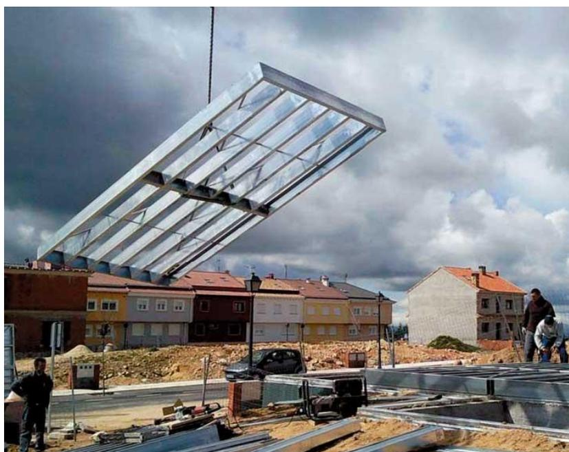
Ilustración 31: Ejemplo montaje panel Cuatro50
