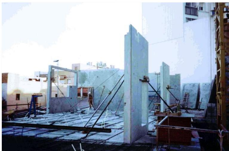
Ilustración 18: Instalación módulos BSCP
