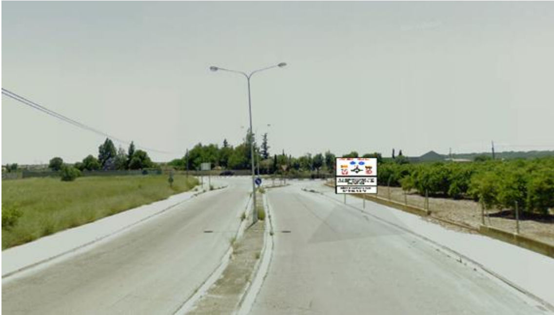
Fig. 102 Estado de la vía tras la aplicación de la medida de mejora para la glorieta del P.K. 1+000 de la CV-333
