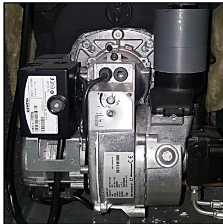
Figura 16. Instalación de acoplamiento
