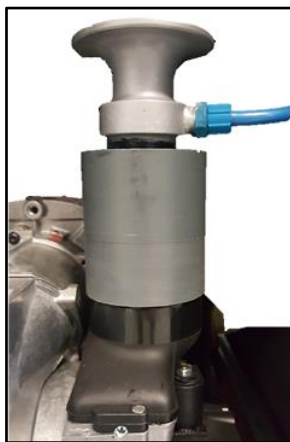
Figura 19. Tobera de la caldera instalada
