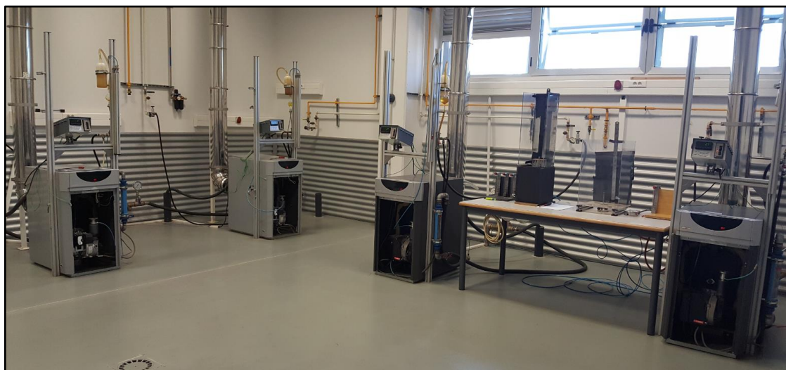
Figura 5. Laboratorio de Transmisión de Calor
