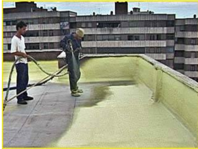
Foto 2 : Proyección de espuma de poliuretano
