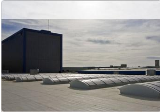
Foto 18 : Cubierta ejecutada con membrana de FPO
