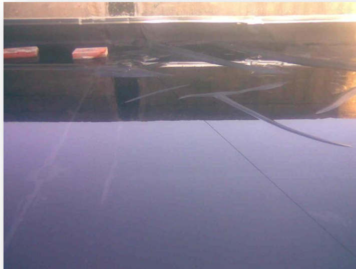
Foto 35 Detalle de sumidero tapado para prueba de estanqueidad
