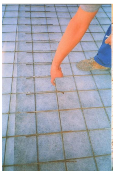
Foto 23 Perforación de la tela con el mallazo
