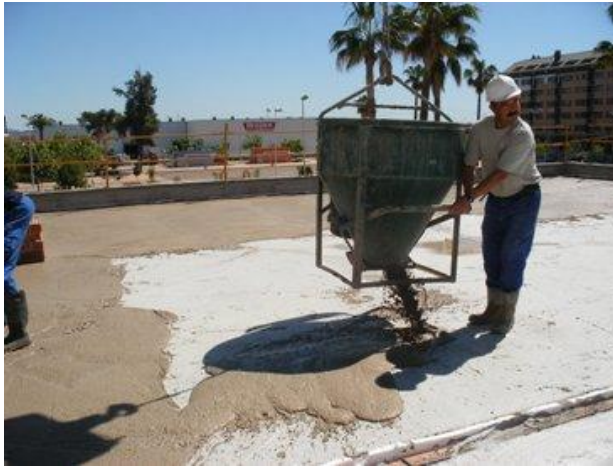
Foto 8 :Ejecución capa de mortero
