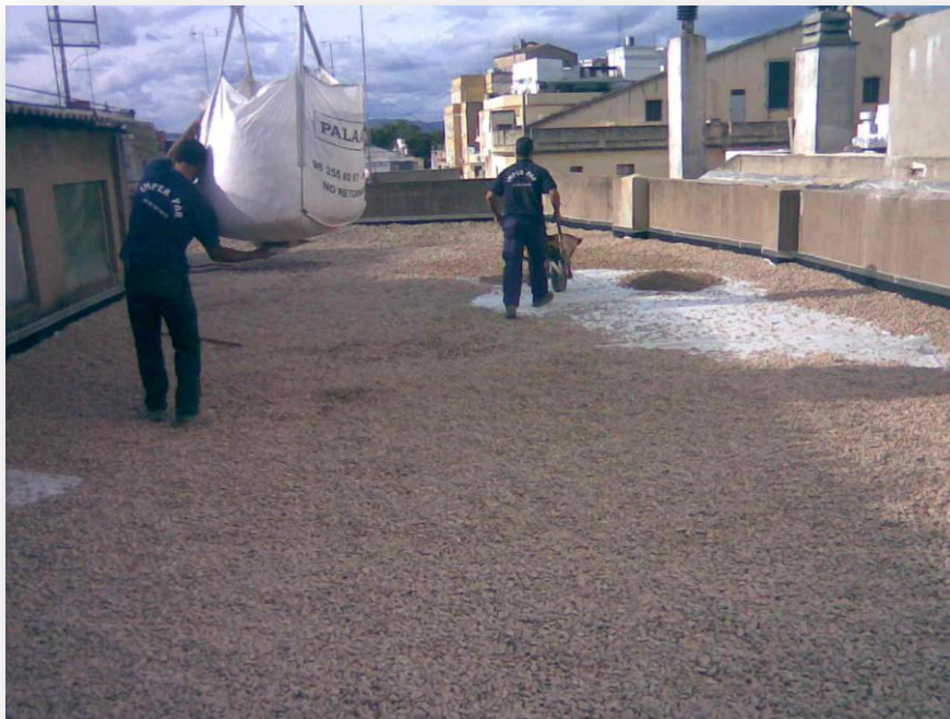
Foto 38 Extendido de capa de grava en sacas de 1m3 de capacidad. Sacas con dosificador inferior para facilitar el extendido mediante grúa.
