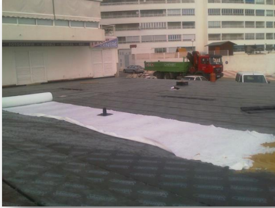
Foto 53 Colocación de lámina geotextil de separación de lámina impermeabilizante y pavimento
