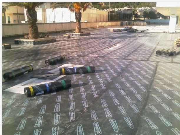
Foto 47 Refuerzo en sumidero
