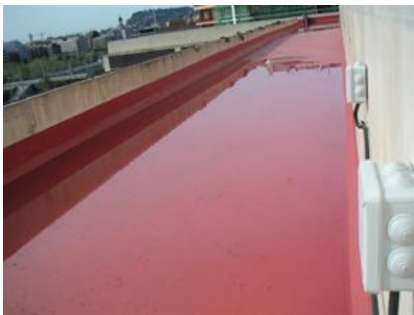
Foto 19 : Cubierta ejecutada con membrana líquida in situ
