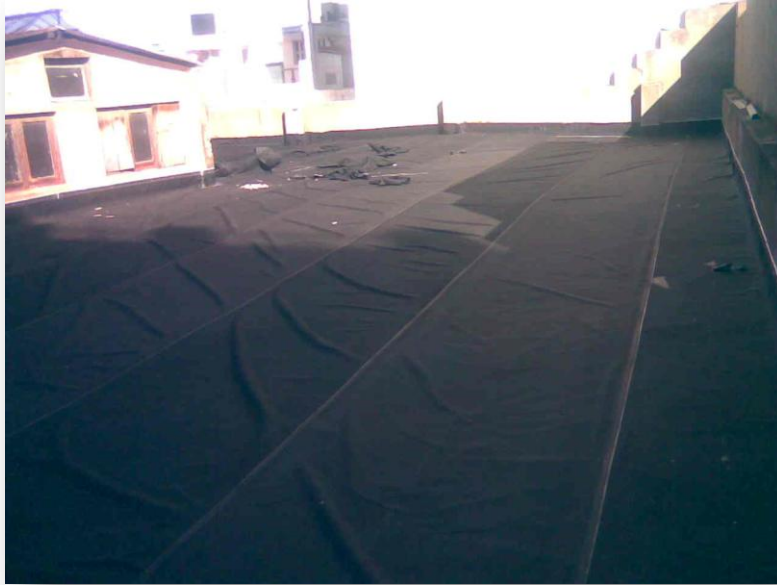
Fotos 30-31 : Lámina de EPDM extendida en toda la superficie de la cubierta
