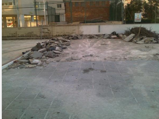
Fotos 39-40-41: Demolición del pavimento
