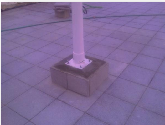
Foto 59 Relleno de junta de pavimento con masilla de poliuretano
