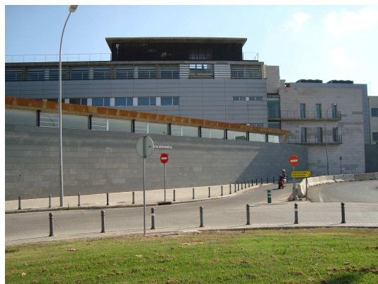
- Figura 56- Fachada Biblioteca Facultad Informática
