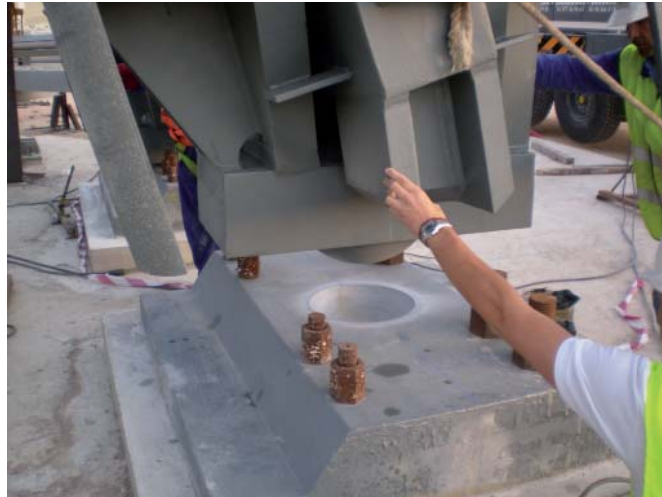
Fotografía de colocación de la pieza de unión de arcos a su rótula. (RA)
