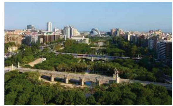
Fotografía aérea, tramos 7 a 9. Puente del Real en primer plano
