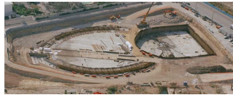
Izquierda. Ejecución de losa y pilotaje. Derecha. Ejecución de muros de Sala Técnica.
