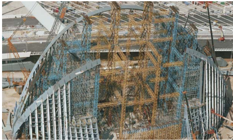
fotografía aérea, donde se muestra la disposición del arco A1, por medio de torres de apeo.
