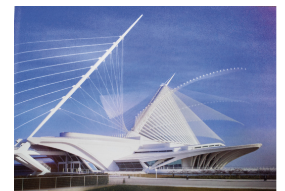
En planta, 163 elementos lineales de acero denominados lamas (82 a un lado y 81 al otro)
