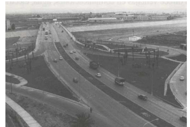
Arriba, obras del Plan Sur. Bajo, Avenida del Cid a su paso por el nuevo cauce.
