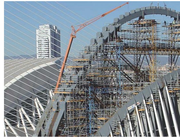
Inicio del montaje del arco de sección triangular (A2) que sirve de apoyo a los pares de semipórticos
