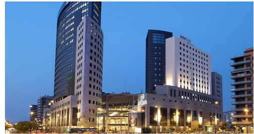
Figura 78 Vista centro comercial Aqua
