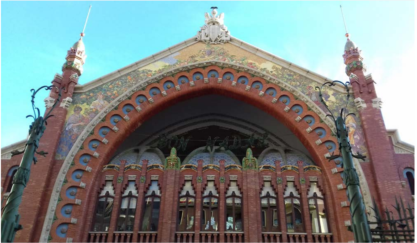
Fachada del Mercado de Colón de Valencia.
