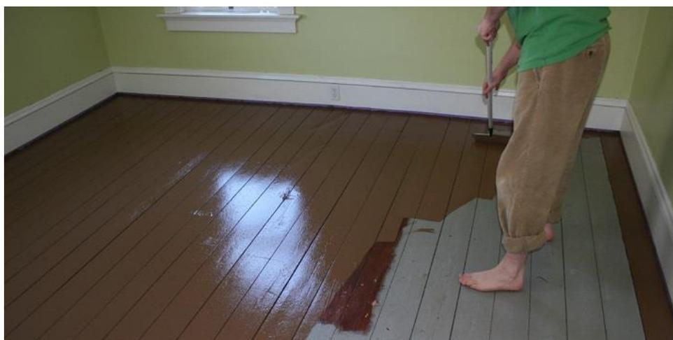
Figura 1.1 Pittura con resina per suoli
