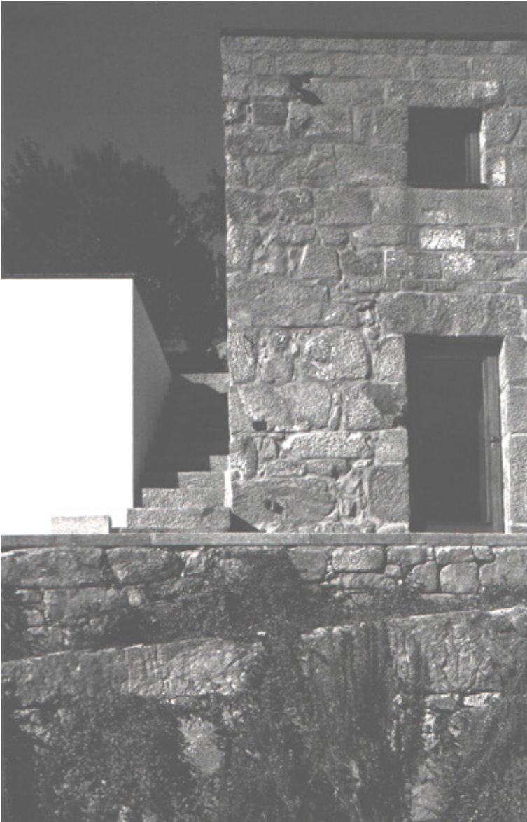
Adalberto Dias, Casa en Penha Longa, 1994-00. El nuevo volumen que se une al existente, separado por una escalera, está construido con la misma técnica que emplea el granito, sin embargo esta vez acabado con revoque blanco (véase también la foto en la p. 511).
