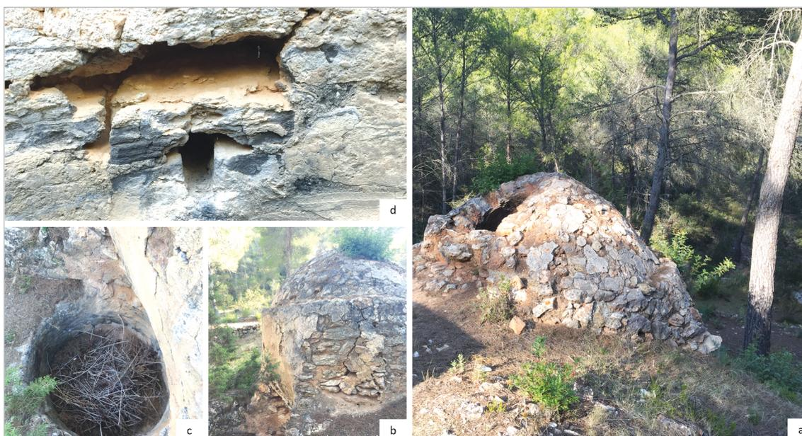
**Figura 6.** Horno de alquitrán de Ses Marrades de Corona (Santa Agnés de Corona): a) vista posterior con la boca parcialmente derruida; b) vista lateral en la que se aprecia *s'olla* en la parte inferior; c) detalle de *s'olla*; d) detalle de la salida del *rajador* a *s'olla* (*es forat*), ennegrecido por el goteo del alquitrán.
