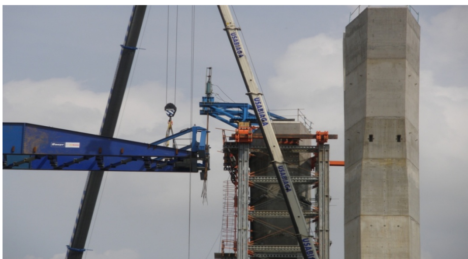
Figura 3.36. Maniobra de recuperación de flecha, mediante el empleo de pórticos.
