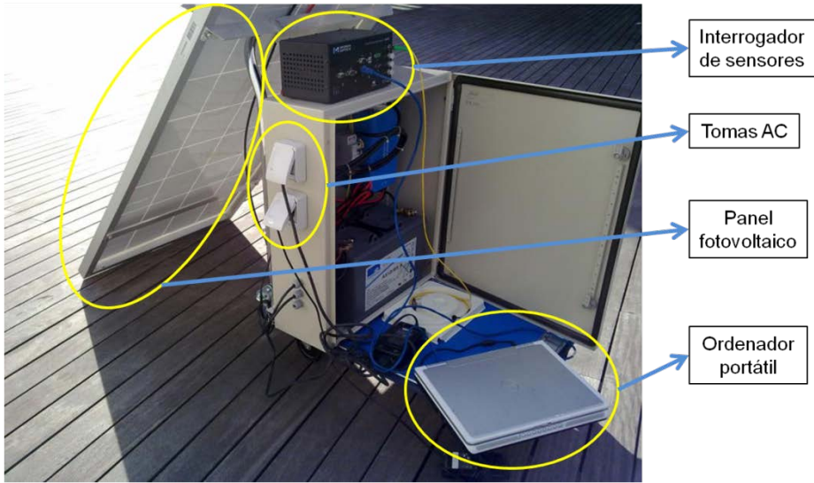
Figura 3.16. Montaje del sistema fotovoltaico adquirido.
