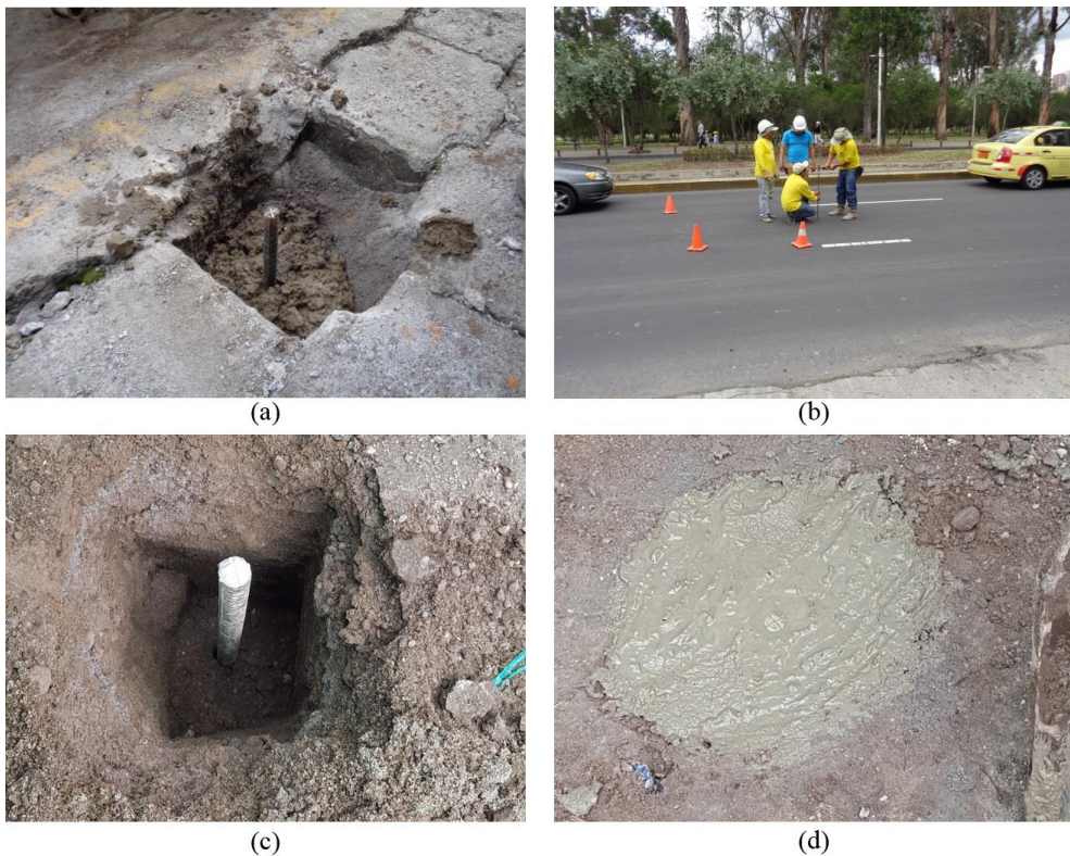
Fig. 4.31 (a) y (b) Instalación de bases de nivelación en proyecto Torre Centre , (c) y (d) Instalación de bases de nivelación en proyecto Zaigen .
