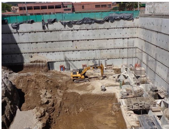
Fig. 1.1 Estructura de “Soil Nailing” en sótanos de edificios en la ciudad de Quito.
