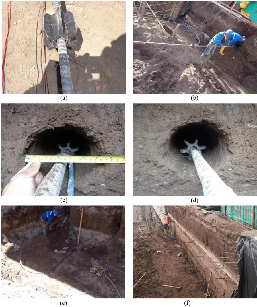
Fig. 4.20 Construcción de “Soil Nails” para muros: (a) centrador de barras de acero, (b) ingreso de barra de acero en perforación, (c) barra de acero en perforaciones para anclajes de muros de Torre Centre, (d) barra de acero en perforaciones para anclajes de muros de Zaigen, (e) inyección de “Grout” en anclajes para muros de Torre Centre, y (f) inyección de “Grout” en anclajes para muros de Zaigen.
