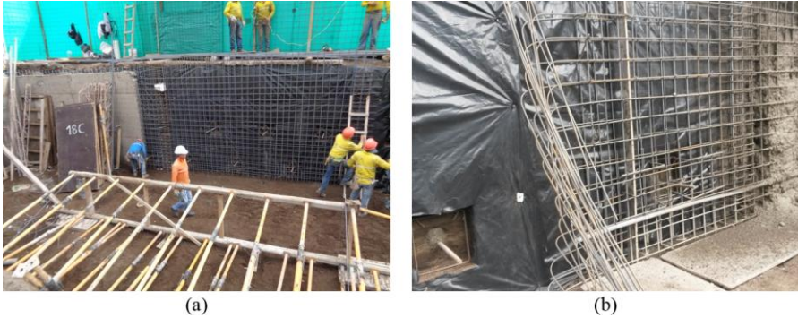
Fig. 4.21 Colocación de acero de refuerzo para muro de Torre Centre , y (b) Colocación de acero de refuerzo para muro de Zaigen .
