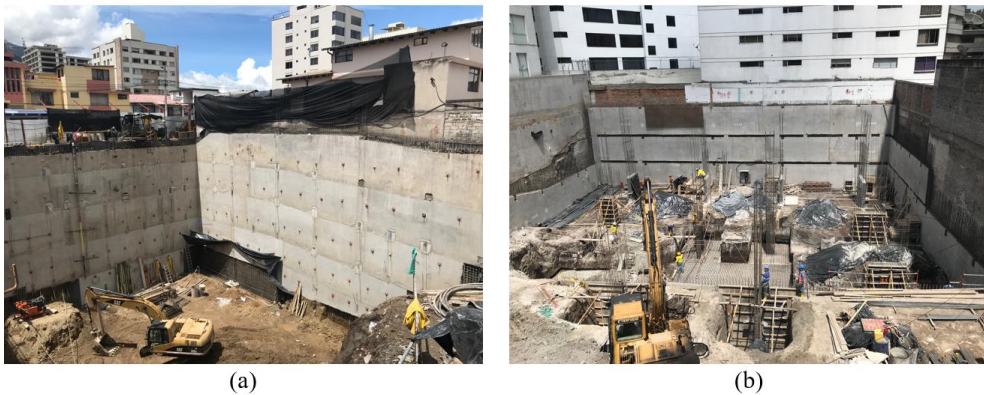
Fig. 2.20 Construcción de niveles de sótano en edificaciones en la zona centro-norte de la ciudad de Quito: (a) Edificio Sense (enero 2020), y (b) Edificio Narelo (diciembre 2019).
