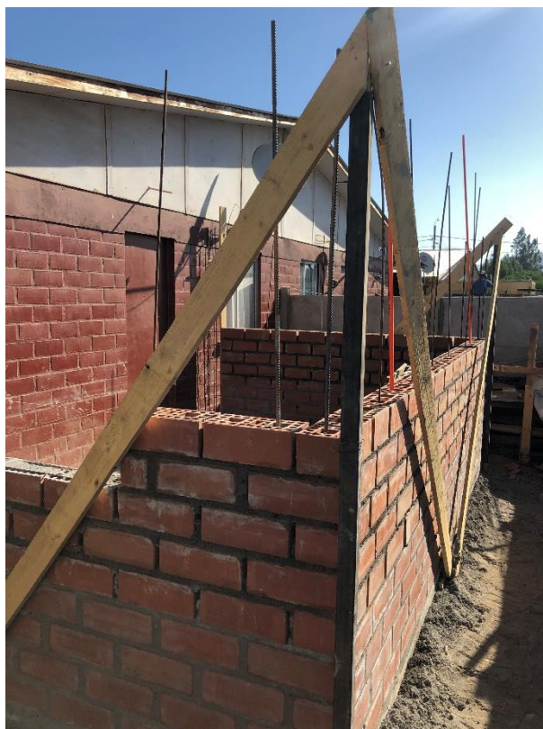
Figura 13 Construcción en albañilería armada (propia)
