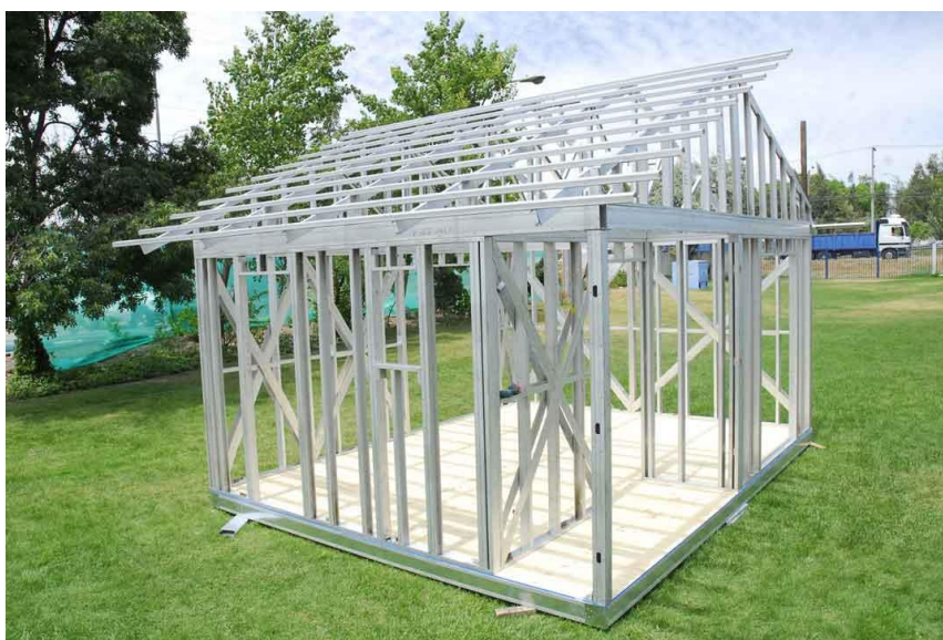
Figura 16 Tabiquería de perfiles de acero galvanizado (cintac.cl)
