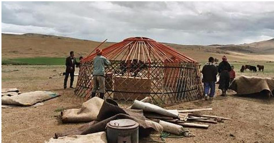
Ilustración 1, Estructura yurta en proceso de armado, L. GAMBAATAR.
