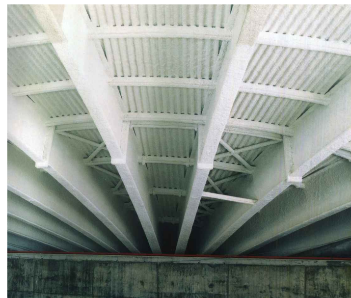
(Figura 6.10) Protección ignífuga
