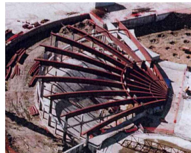
(Figura 5.3) Vista exterior de las vigas
