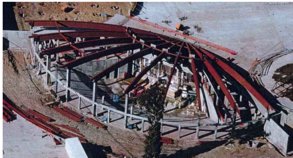
(Figura 6.3) Vigas colocadas
