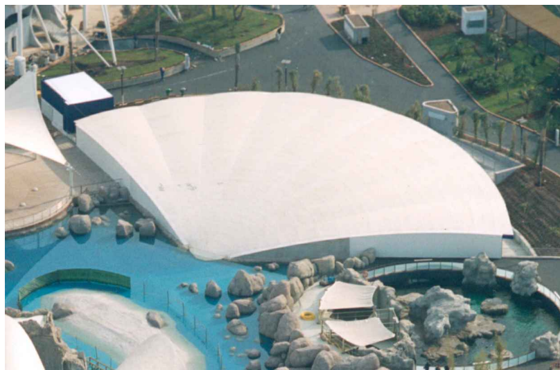
(Figura 6.2) Cubierta finalizada
