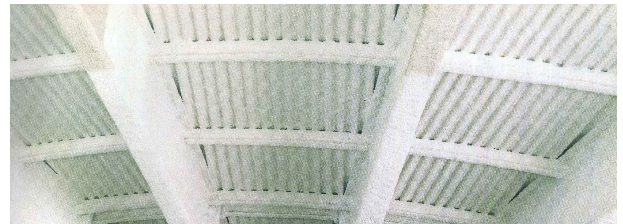
(Figura 5.5) Unión de las correas con las vigas con el tratamiento ignífugo ya proyectado
