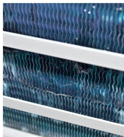
Figura 28. Hielo acumulado en la parte inferior del intercambiador de aire
