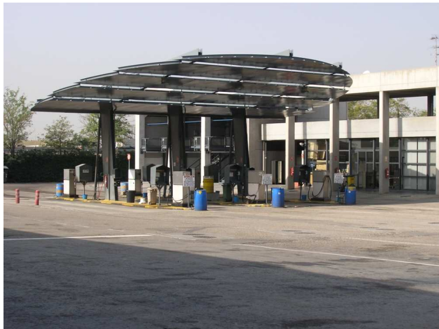
Figura 11. Estación de repostaje San Isidro.
