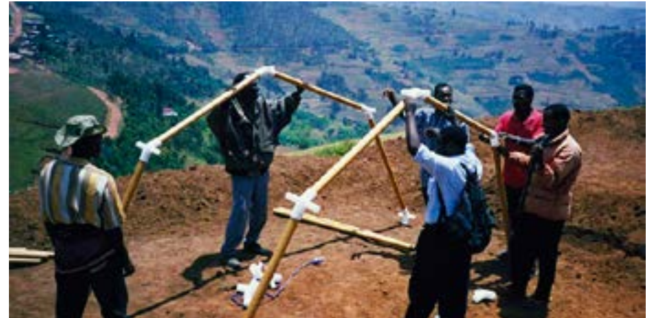
Construcción de un Refugio de Papel, Ruanda. http://www.shigerubanarchitects.com/works/1999_paper-emergency-shelter/050207_003.jpg
