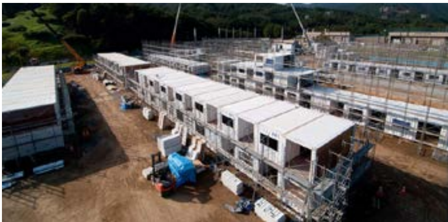
Construcción de las Viviendas - Contenedor Temporal http://www.shigerubanarchitects.com/works/2011_onagawa-container-temporary-housing/UC.jpg
