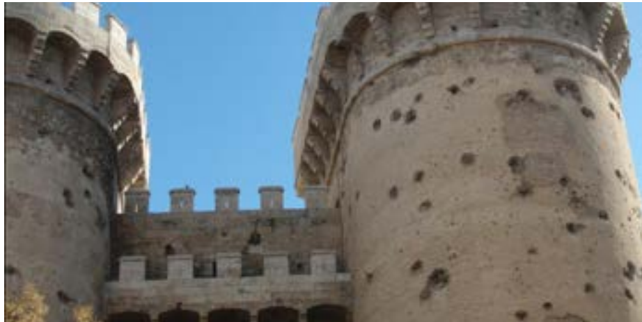
Desperfectos causados por metralla que forman parte de la historia de las Torres de Quart, Valencia, España. www.jdiezamal.com/torresquart01.jpg
