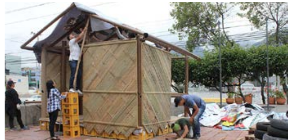
Construcción del Refugio mixto como mejora del Refugio de Papel, Manta, Ecuador. http://www.shigerubanarchitects.com/works/2016_Ecuadorproject/IMG_2669.JPG
