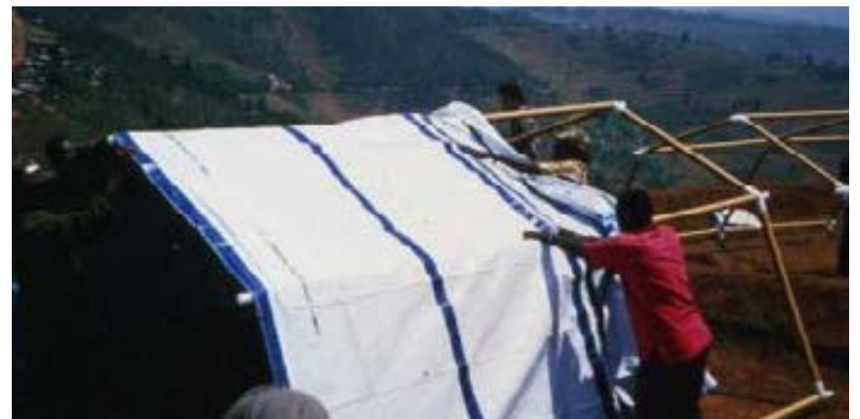
Construcción de un Refugio de Papel, Ruanda. http://www.shigerubanarchitects.com/works/1999_paper-emergency-shelter/shelter_construction1.jpg
