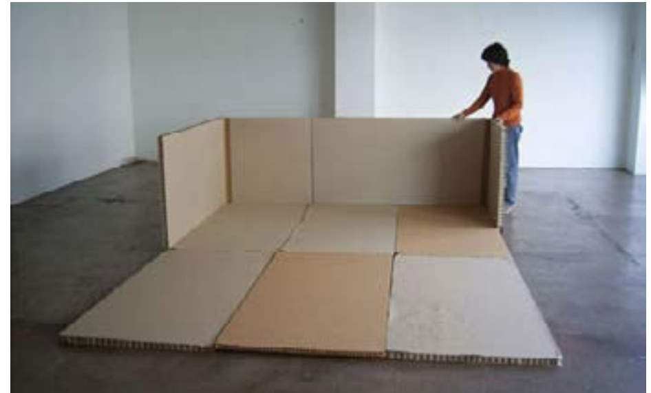
Planchas de cartón para mejorar la intimidad en el Sistema de Partición de Papel (PPS-2), Fukuoka, Japón. http://www.shigerubanarchitects.com/works/2005_paper-partition-system-2/pps2.JPG
