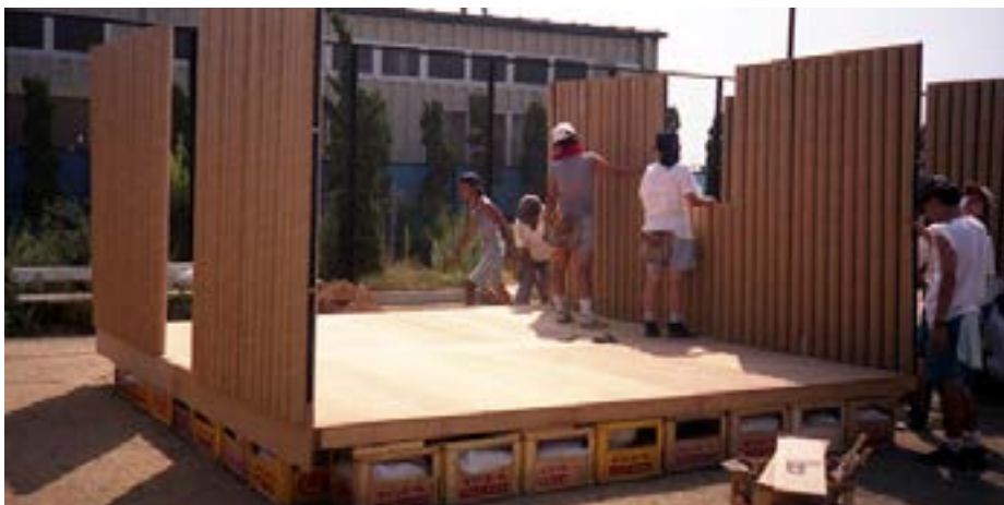
Construcción de un Refugio de Tubos de Papel, Kobe. http://www.shigerubanarchitects.com/works/1995_paper_log_house_kobe/PLH-K-Const-05.jpg
