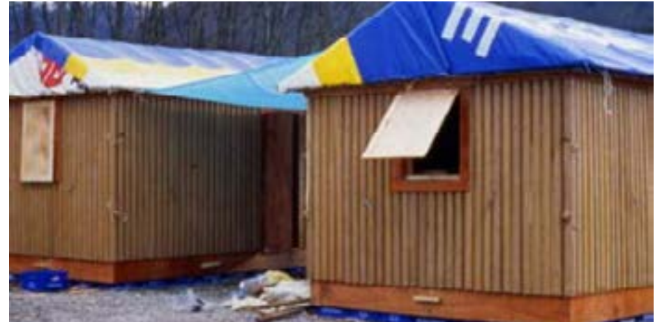
Refugio de Tubos de Papel, Turquía. http://www.shigerubanarchitects.com/works/2000_paper-log-house-turkey/turkey1.jpg
