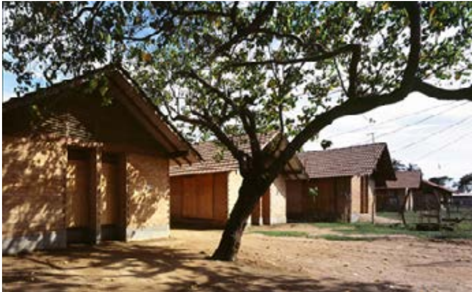
Vista exterior de la casa de Bloques de Tierra Cimprimida (CEB), Kirinda, Sri Lanka. http://www.shigerubanarchitects.com/works/2005_kirinda-house/EW131-03.jpg
