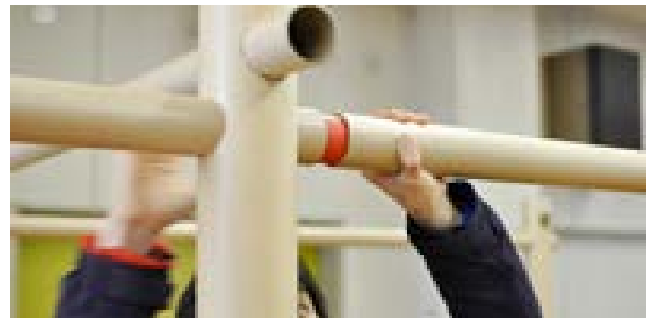
Montaje del Sistema de Partición de Papel (PPS-4) Tohoku, Japón. http://www.shigerubanarchitects.com/works/East-Japan-Earthquake2011/pps4/20110323-4.jpg
