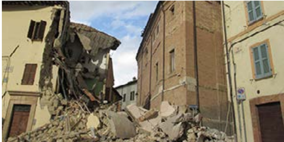
Destrucción de edificios tras un terremoto en Camerino, Italia http://www.shigerubanarchitects.com/works/2016_camerino/Camerino_IMG_1176.JPG
