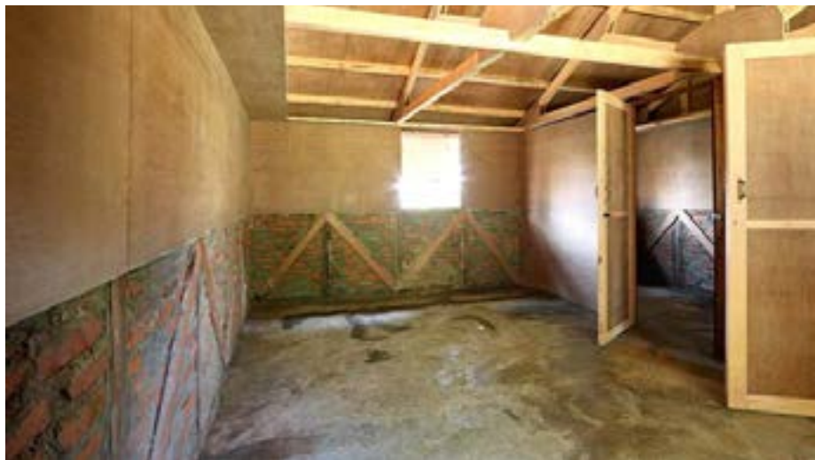
Interior construido de la vivienda refugio de Marcos de madera y bloques, Katmandú, Nepal. http://www.shigerubanarchitects.com/works/2015_nepal/2.jpg
