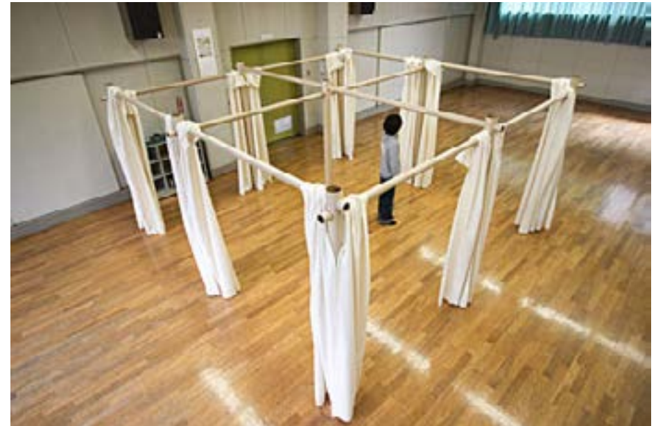
Sistema de Partición de Papel (PPS-4) Tohoku, Japón. http://www.shigerubanarchitects.com/works/East-Japan-Earthquake2011/pps4/20110323-2.jpg
