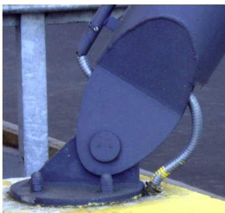
Figura I.5.16: Ejemplo de unión en base de mástiles tipo pasador. Fuente: [Llorens, 2015].
