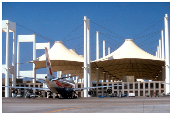
(a) Cubierta aeropuerto Jeddah
