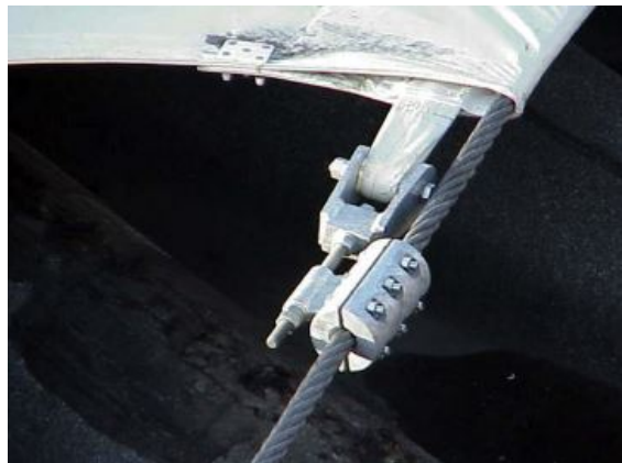
Figura I.5.12: Ejemplo de cinta ajuste de membrana en puño. Fuente: [Llorens, 2015].
