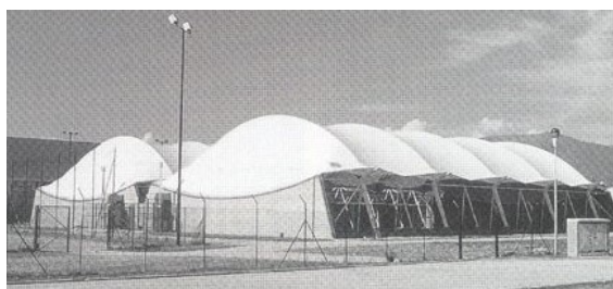
Figura I.1.14: Cubierta pista tenis, Gorle. Fuente: [TensiNet Association].
