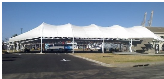
Figura I.1.13: Cubierta estación autobuses, Montevideo. Fuente: [TensiNet Association].
