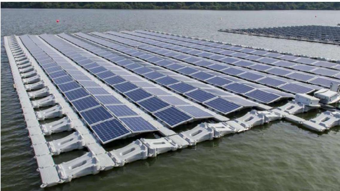
Figura 1: Planta fotovoltaica flotante embalse de Sierra Brava. Fuente: Acciona
