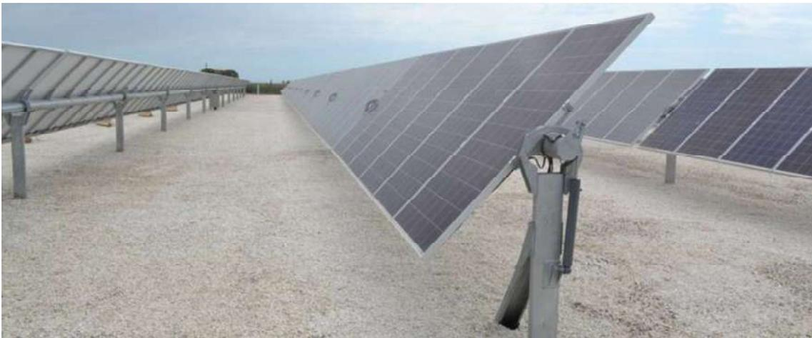
*Figura 2: Estructura de anclaje metálica móvil.*
