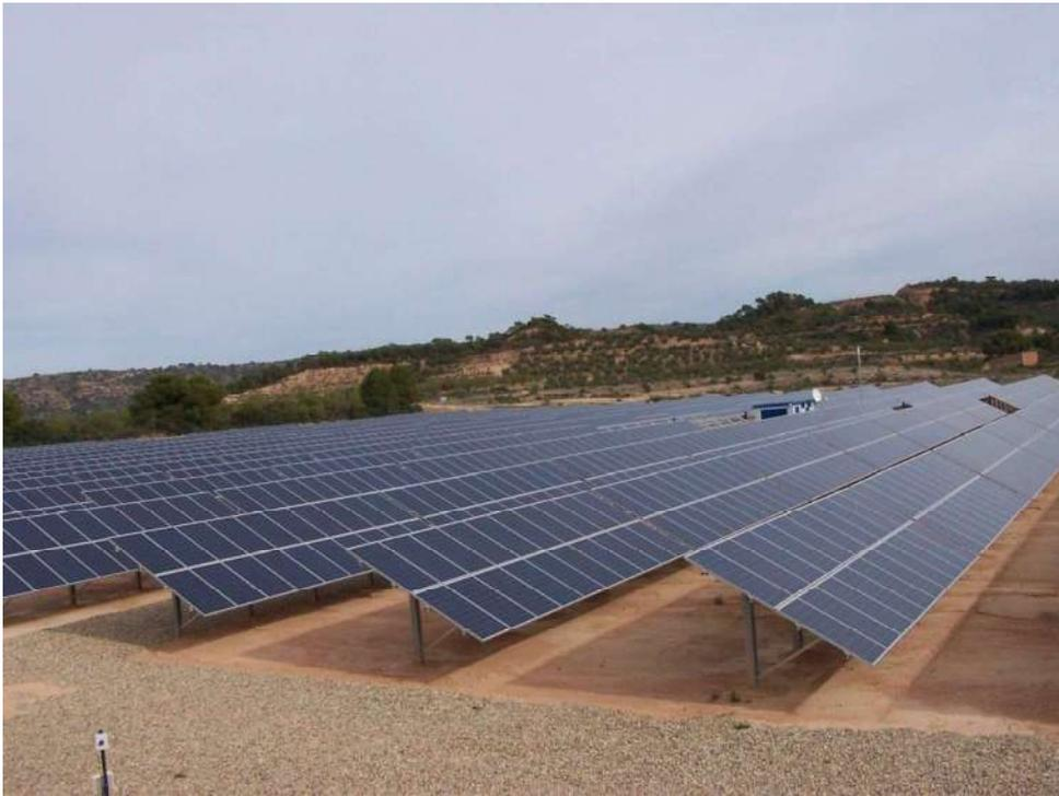
Figura 6: Estructura fija 2V-5H. Fuente: Suntechnics Energías Renovables S.L.
