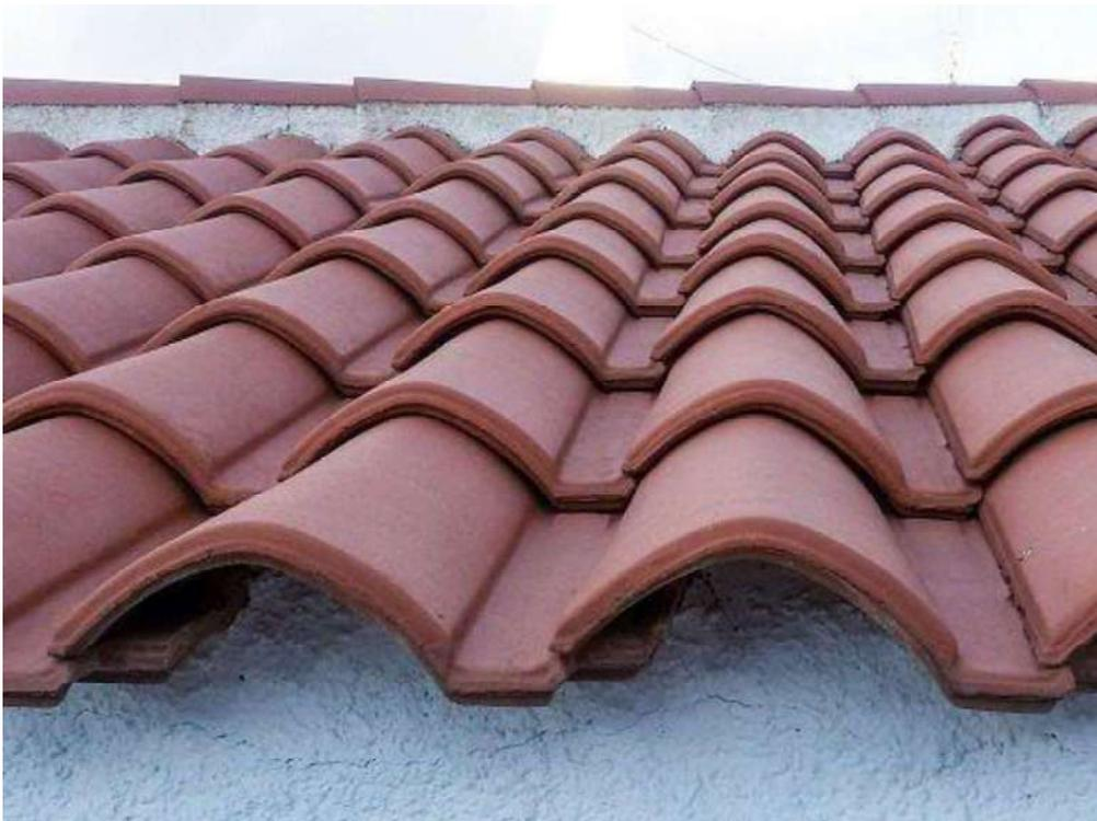
Figura 9: Cubierta teja cerámica mixta
