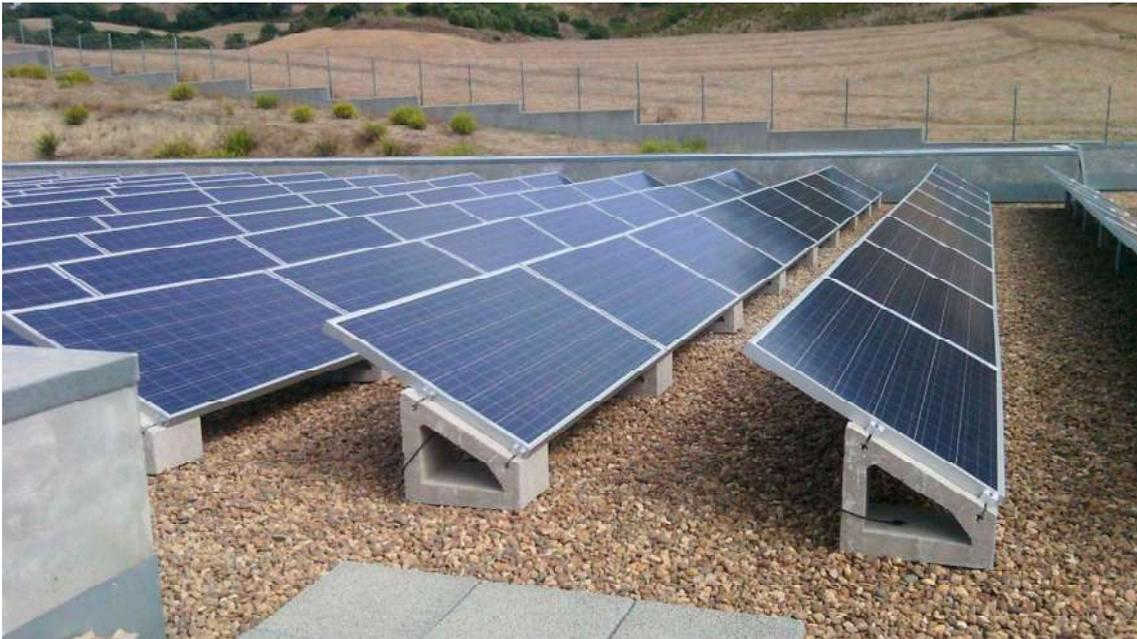
Figura 5: Estructura lastrada. Fuente: Solarbloc.es
