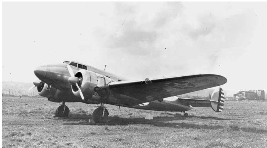
Ilustración 1: Lockheed XC-35, el primer avión construido con la cabina presurizada. (Saldeño, 2020)
