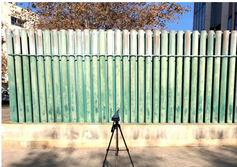
Figura 1: Pantalla basada en cristales de sonido
