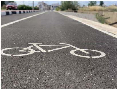
Pavimento de carriles bici - UPV
