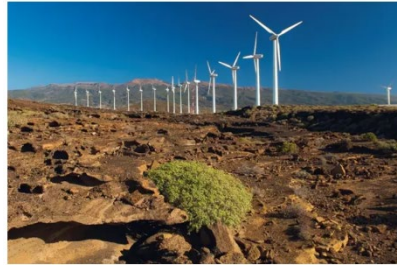
Aerogeneradores en las instalaciones del Instituto Tecnológico y de Energías Renovables (ITER), dependiente del Cabildo de Tenerife - CABILDO DE TENERIFE
