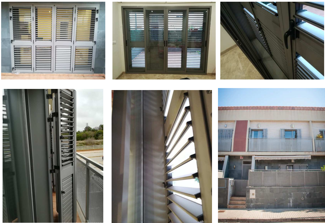
Figuras 19. Imágenes de los huecos de fachada. Fuente: Elaboración propia
