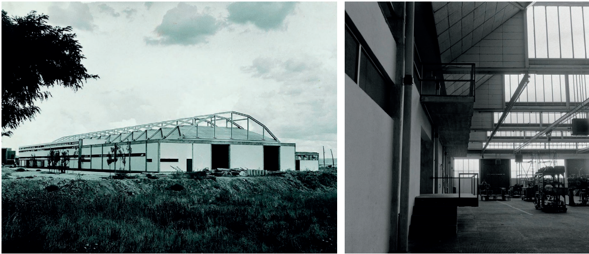
Figura 4. Alejandro de la Sota, T.A.B.S.A. Edificio para banco de pruebas de motores, Madrid, España, 1957, imagen del exterior y del interior. © Fundación Alejandro de la Sota. https://archivo.alejandrodelaSota.org/es/original/project/313
