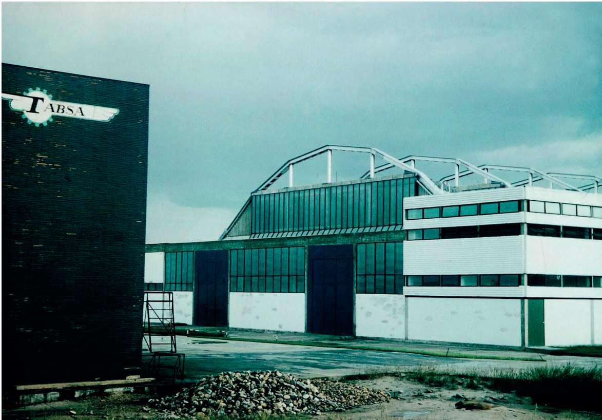
Figura 3. Alejandro de la Sota, T.A.B.S.A. Edificio para banco de pruebas de motores, Madrid, España, 1957. © Fundación Alejandro de la Sota, https://archivo.alejandrodelasota.org/es/original/project/313
