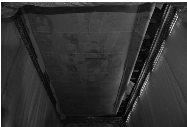
Figura 15. Imagen de la operación de descenso de la obra de la Sala Heráldica
