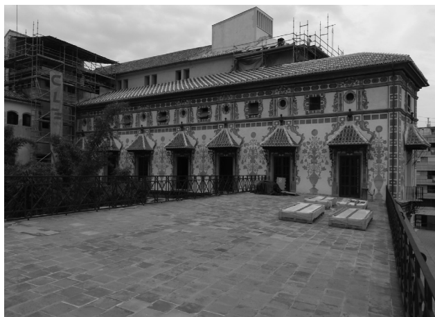
Figura 1. Vista general del exterior de la Galería Dorada
