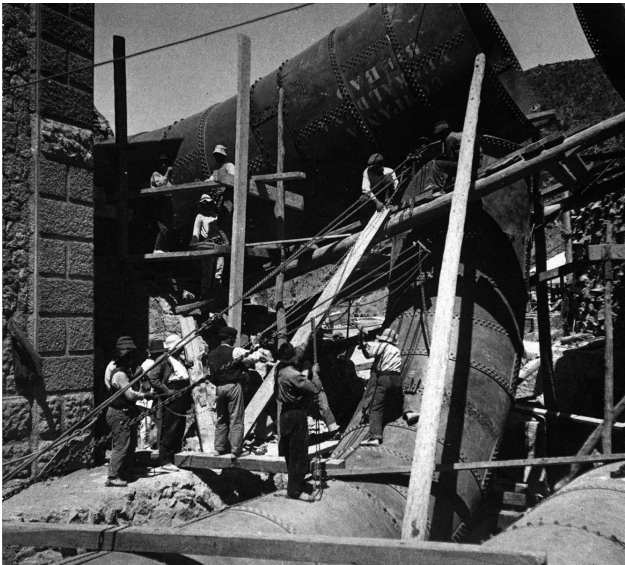
Figura 3. Colocación de las alzas y colocación de las dos primitivas tuberías forzadas (Fuente: Archivo Histórico de Iberdrola, hacia 1914)
