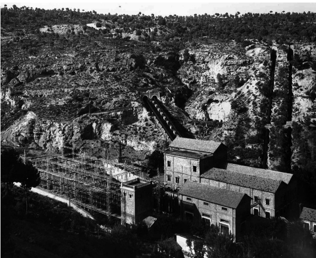
Figura 4. Exterior e interior de la Casa de Máquinas de Villora. En el exterior también se distinguen la Subestación, la Salida de Líneas y las cuatro Tuberías Forzadas. En el interior y en primer término, los dos grupos que entraron en servicio en 1914; al fondo los dos grupos verticales instalados en las ampliaciones de 1925 y 1945. (Fuente: Archivo Histórico de Iberdrola)
