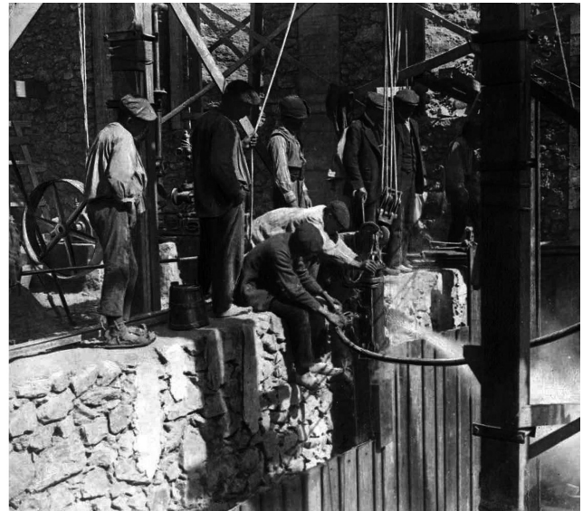
Figura 3. Colocación de las alzas y colocación de las dos primitivas tuberías forzadas (Fuente: Archivo Histórico de Iberdrola, hacia 1914)
