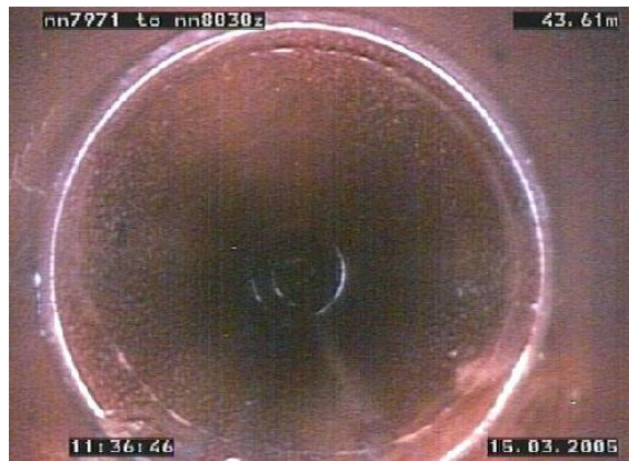
Figura 16. Rotura circular
