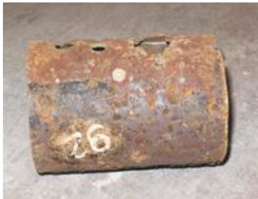
Figura 20. Hoyo producido por corrosión
