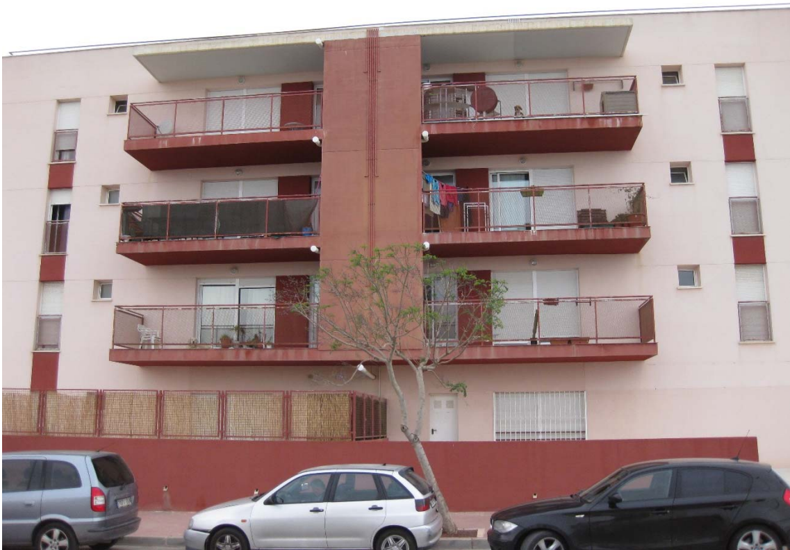
5. Fachada SE, Local de Comunidad.
