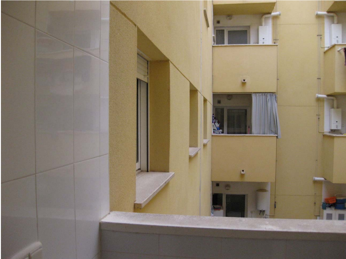
6. Fachada patio interior.
