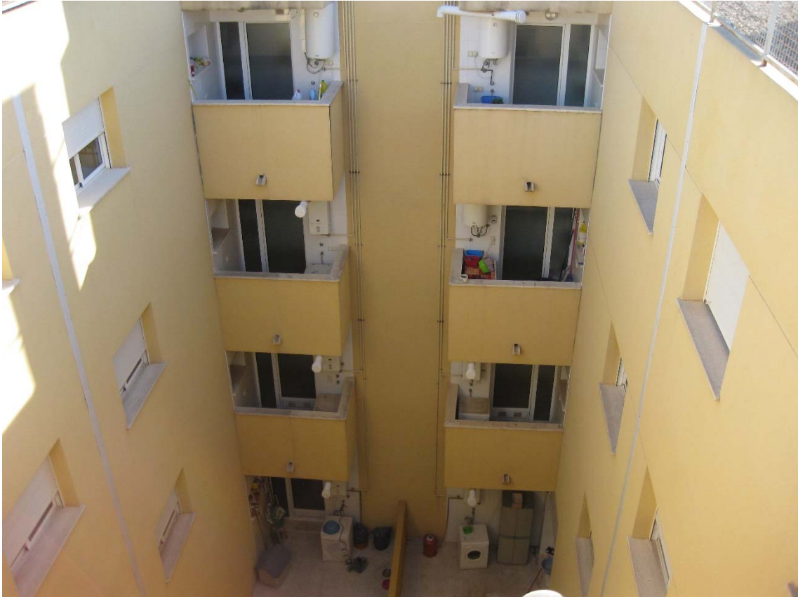
8. Fachada patio interior.
