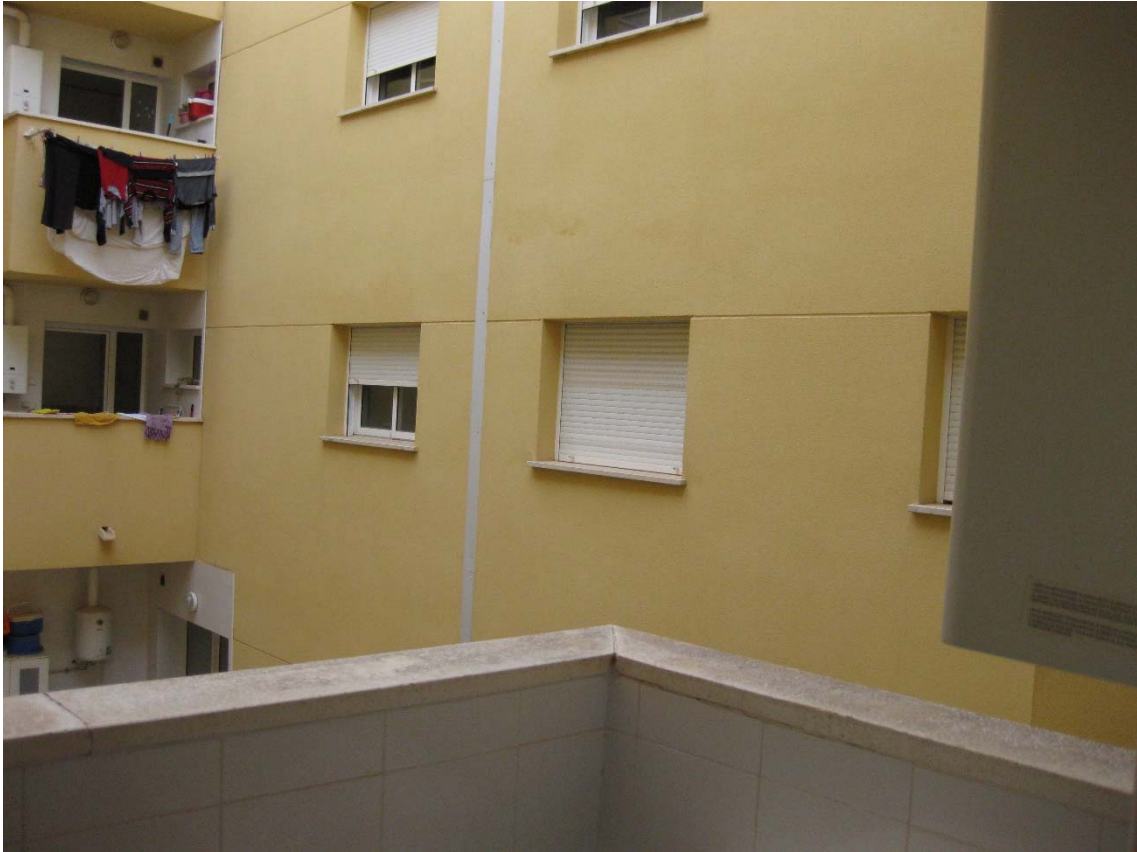
7. Fachada patio interior.
