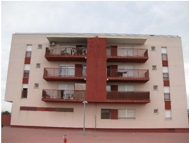
Figura 10. Fachada NO. 2014. Propia.
