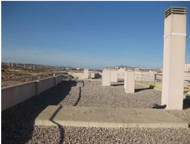
Figura 22. Vista de cubierta con bancadas vacías. 2014. Propia.
