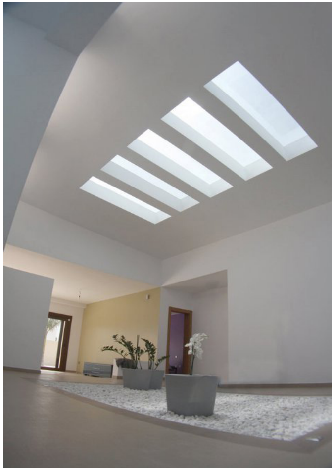
Detalle de lucernario en residencia privada en Costa Teguiise, t.m. De Teguiise, mediante vidrio laminado.
