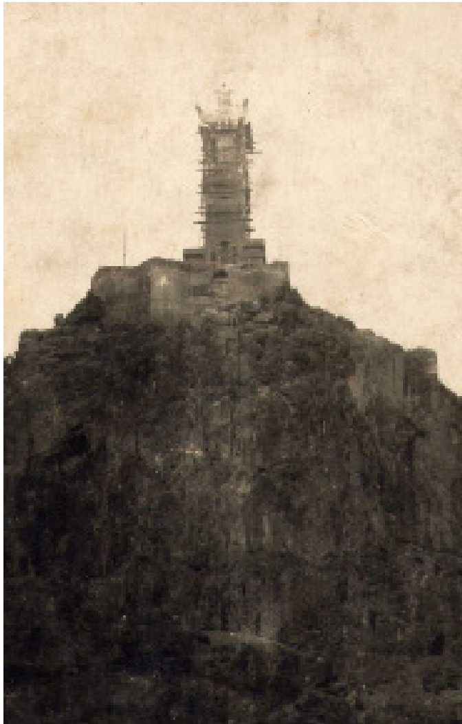
Andamiaje para la colocación del Primer Monumento al Sagrado Corazón de Jesús de Monteagudo . 1925 Piedra, 20 m altura Anastasio Martínez Hernández Nicolás Martínez Ramón
