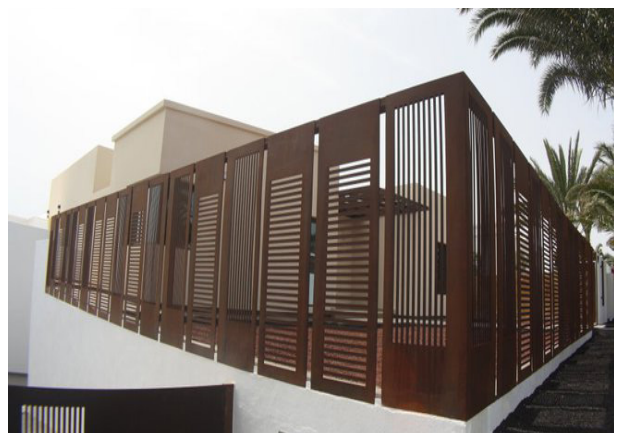
Detalle de cerramiento en residencia privada realizado mediante corte al agua de chapa de acero corten y ensamblado mediante soldadura.
