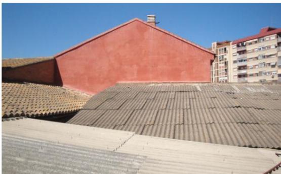
Figura 38 Vistas de las cubiertas con placas de fibrocemento. Propio autor
