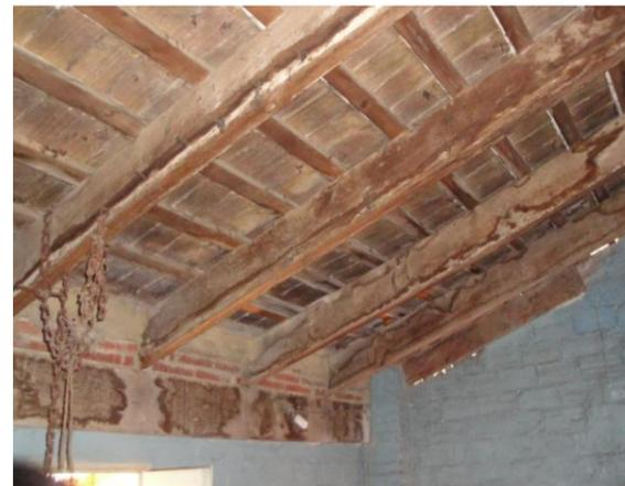
Figura 37: Cubierta a un agua del mismo tipo que la anterior descrita, cubre el espacio de la segunda planta y la escalera de acceso. Propio autor
