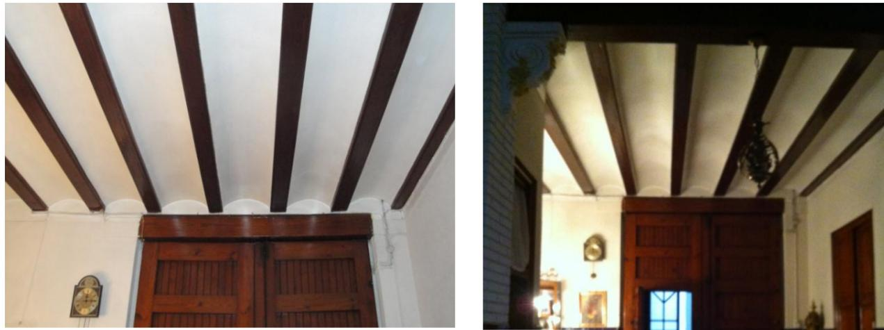
Figura 32: Vistas del forjado de viguetas de madera y revoltones. Propio autor
