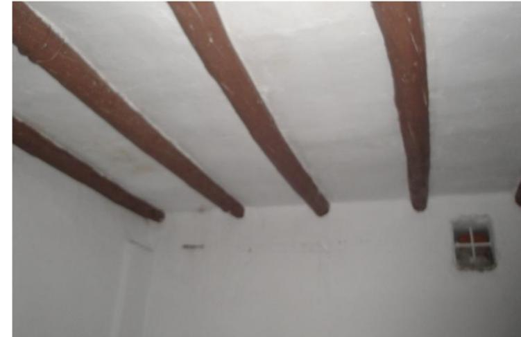
Figura 34: Forjado de viguetas de madera de rollizo, en las habitaciones de la parte posterior. Propio autor
