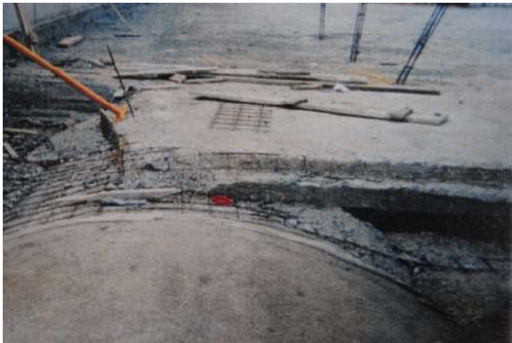
Figura 14. Cubierta del museo en construcción 1998. Museo de Historia de Valencia
