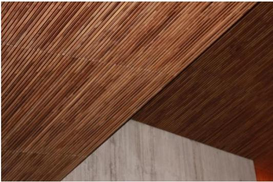
Figura 159 Detalle falso techo
