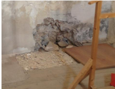
Imagen 13. Cata en la cara interior del muro. 2014. Fuente: J.C.A.
