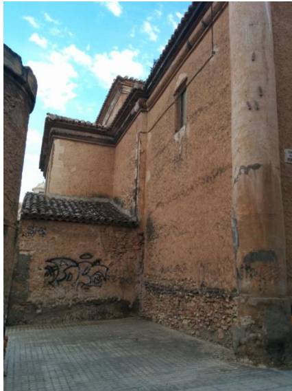
Imagen 26. Detalle fachada oeste. 2014. Fuente: J.C.A.
