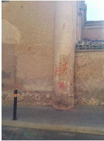
Imagen 31. Fachada oeste. 2014. Fuente: J.C.A.
