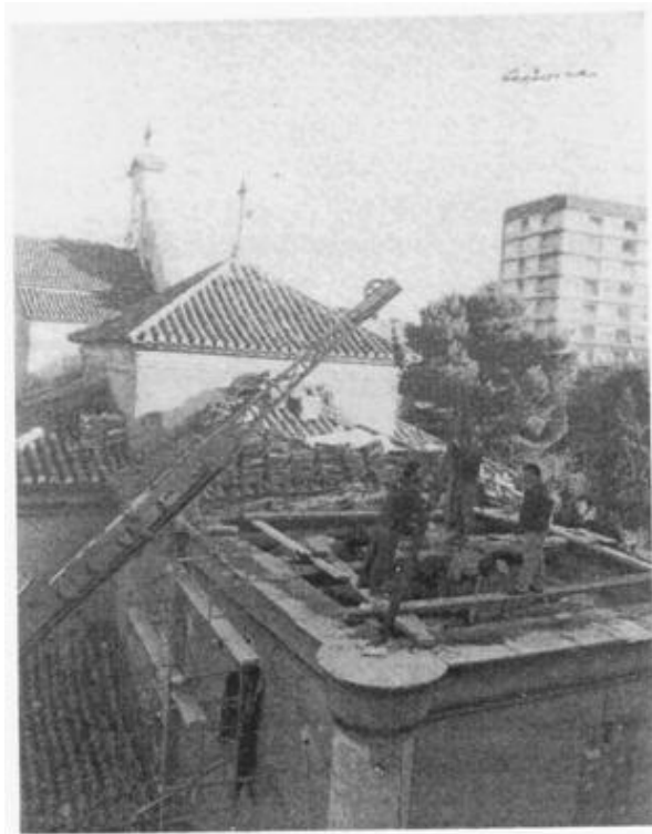
Imagen 11. Obras en cubierta. 1991. Fuente: Juan Victoria.
