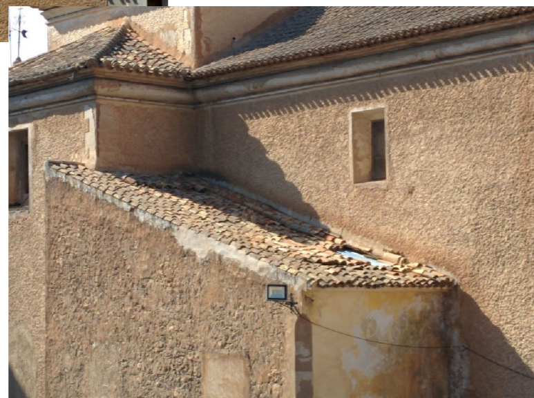
Cubierta capillas laterales en la fachada sur.
