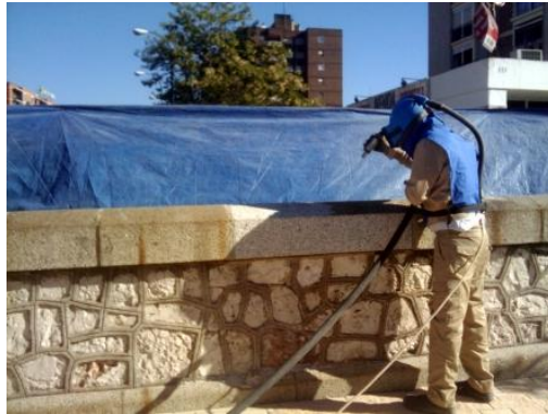
Imagen 33. Limpieza con chorro de arena. 2015. Fuente: G.A.P.S.L.
