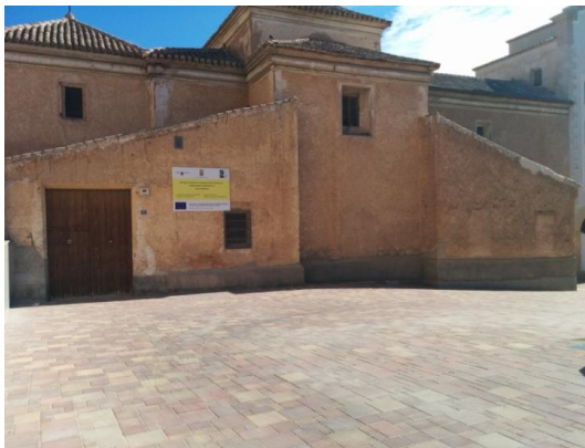
Imagen 30. Fachada sur. 2014. Fuente: J.C.A.
