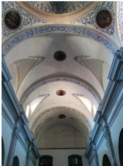
Imagen 15. Bóveda de cañón, nave central. 2014. Fuente: J.C.A.
