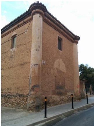
Imagen 14. Contrafuertes camarín. 2014. Fuente: J.C.A.
