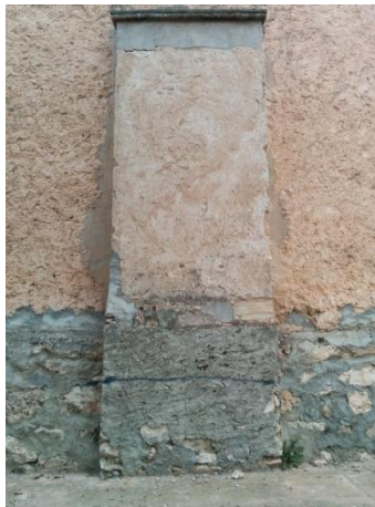
Imagen 35. Rejuntado en fachada norte. 2014. Fuente: J.C.A.
