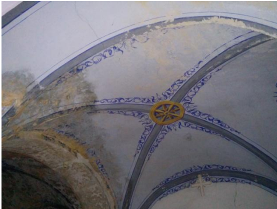
Imagen 18. Bóveda de arista. 2014. Fuente: J.C.A.
