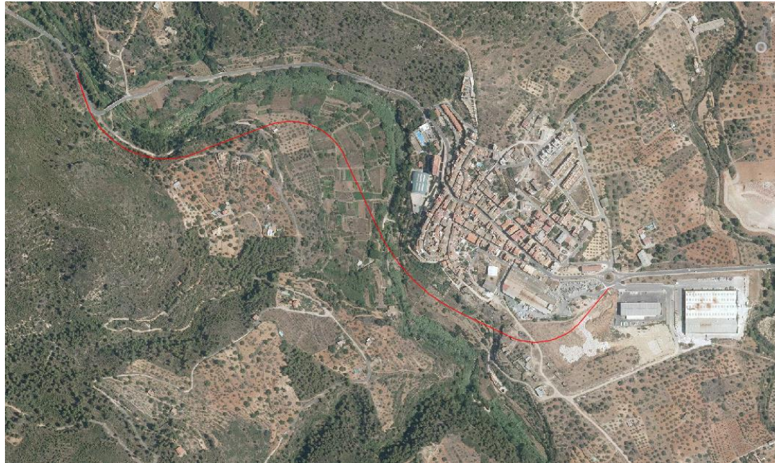
Fig. 1. Trazado de la carretera en su paso por el cauce.
