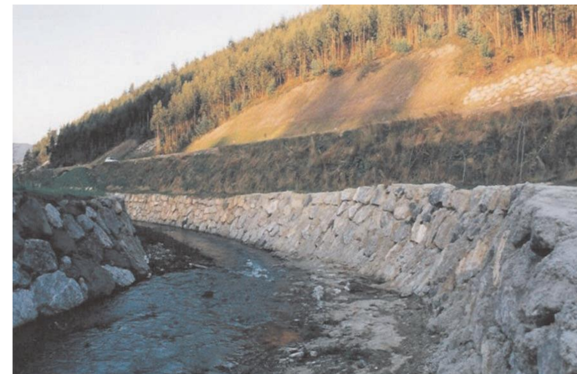
Fig. 34. Imagen de muro de escollera en un cauce.
