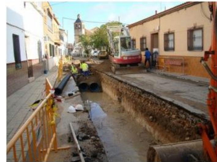
Imagen 2. Ejemplo de colector enterrado en área urbana
