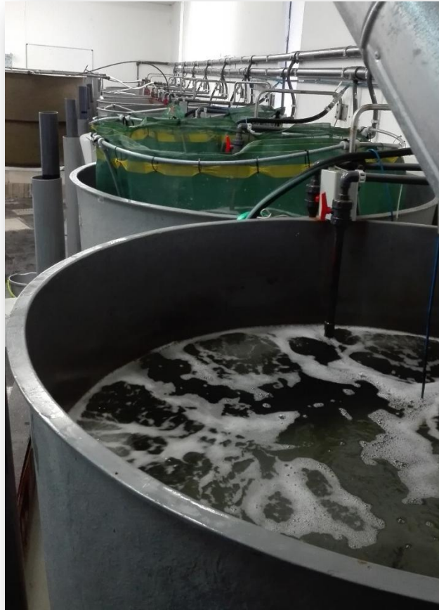
Figura 6. Tanques del sistema de baja temperatura.
