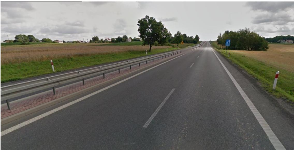
*Figura 15: Fotografía de una de las secciones de la carretera 2+1 en Polonia*
