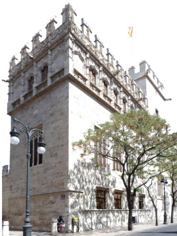
Imagen 28 LONJA DE VALENCIA. Esquina noroeste de la Lonja. El pabellón del consulado del mar en primer plano. Fuente propia.
