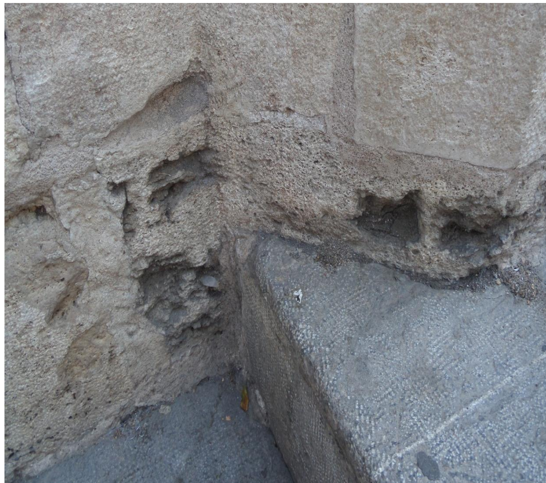
Imágenes 264 ACANALADURAS VERMICULADURAS Y DESAGREGACIONES ARENOSAS por erosión alveolar junto a nuevas exfoliaciones por desplazación en las piedras de las jambas de la Lonja de Valencia. Fuentes propias.
