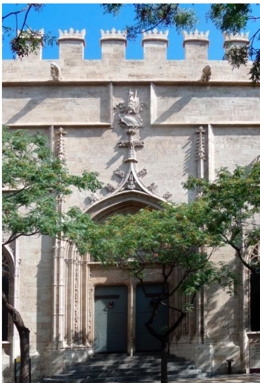
Imagen 1 FACHADA PRINCIPAL DE LA LONJA DE VALENCIA. Fuente propia.
