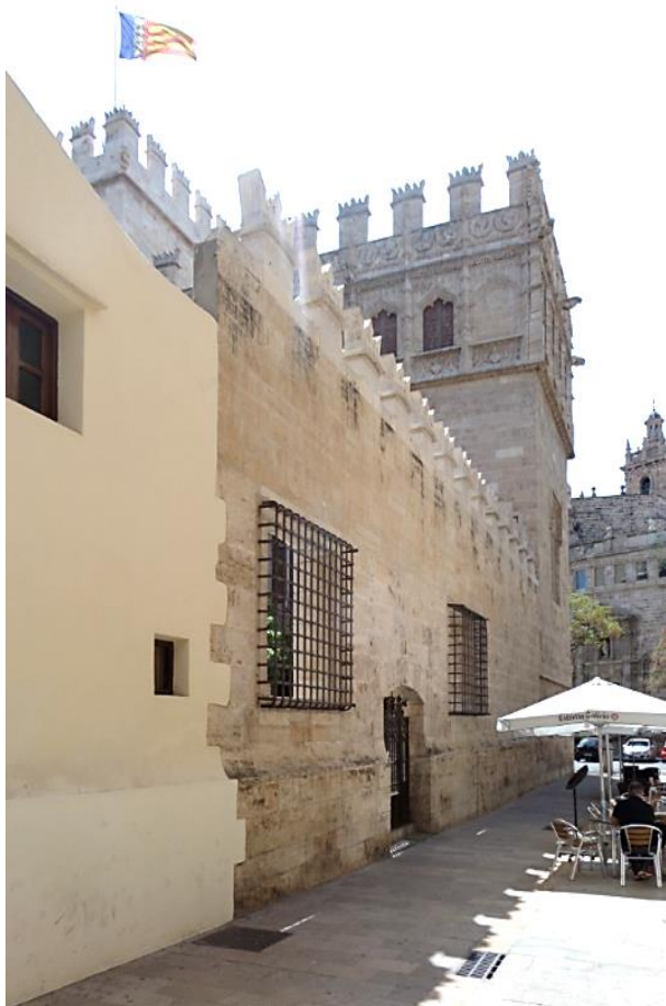
Imagen 79. FACHADA NORTE. Actual calle Cordellats. Se aprecia el encuentro del cerramiento del patio de los naranjos propuesto por Cortina a base de piedra natural con el de las "casuchas" a base de ladrillo enfoscado con mortero y acabado con pintura. Fuente propia
