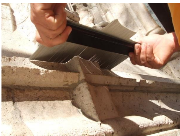
Imagen 215 PEINE ARQUEÓLOGO. Vista del levantamiento del arranque de la caña que vemos en la imagen de la derecha. Fuente propia.
