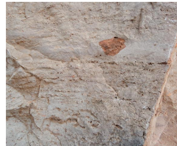
Imagen 120 FRENTE DE CANTERA. Detalle de la piedra existente en el frente de donde se toman los carretales. Fuente propia.
