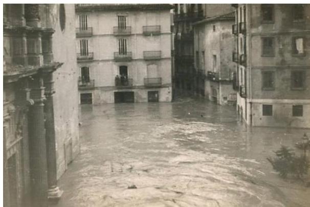
Imagen 13 LA RIADA de 1957. Plaza del Carmen. El agua que se ve pasará a continuación por la fachada principal de la Lonja. Fuente archivo Las provincias.
