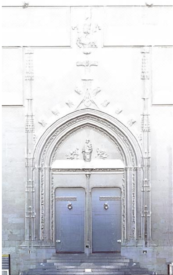
Imagen 86 PORTADA PRINCIPAL DE LA LONJA DE LA SEDA DE VALENCIA. Levantamiento con el escàner l aser 3D. Fuente propia
