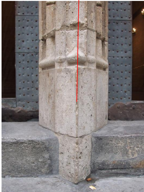
Imagen 206 PARTELUZ de la puerta principal. Se dibuja mediante una línea vertical el origen de la numeración de los planos de sección vertical. Fuente propia
