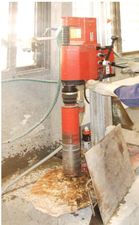
Imagen 118 PROBETAS. Taladro de la marca Hilti modelo DD150-U ejecutando la primera perforación. Fuente propia.
