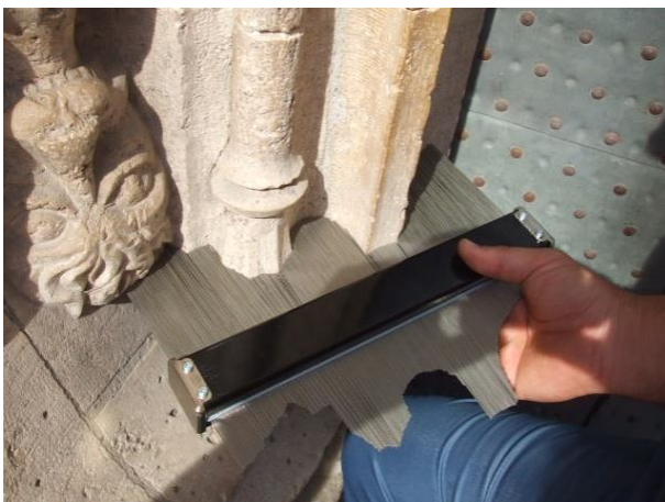
Imagen 219 PEINE ARQUEÓLOGO. Vista del levantamiento del arranque de la caña y moldura que vemos en la imagen de la derecha. Fuente propia.
