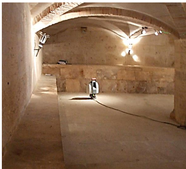
Imagen 64 SEMISÓTANO DEL CONSULADO DEL MAR. A la derecha el banco corrido de la fachada este del consulado. Al fondo la cimentación de la torre en su fachada norte. Vemos también el escáner LEYCA trabajando. Fuente propia
