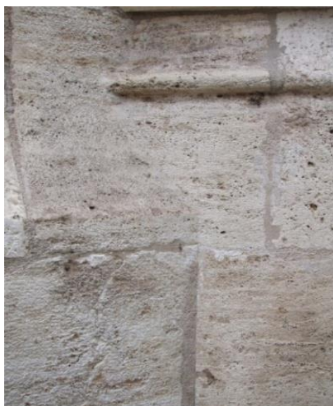
Imagen 257 VISTA GENERAL de la arista vertical que se pretende levantar. Observar que apenas se distingue. Fuente propia.
