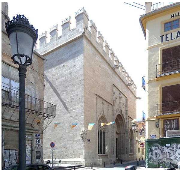
Imagen 26 LA LONJA DE VALENCIA. Esquina sureste del edificio de la Lonja desde la plaza del doctor Collado. Fuente propia.
