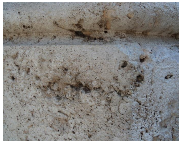
Imágenes 264 ACANALADURAS VERMICULADURAS Y DESAGREGACIONES ARENOSAS por erosión alveolar junto a nuevas exfoliaciones por desplazación en las piedras de las jambas de la Lonja de Valencia. Fuentes propias.
