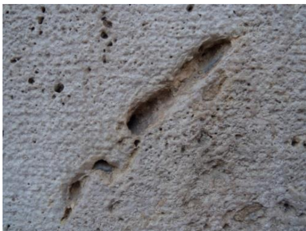
Imagen 137 POROSIDAD. Vista en detalle de la piedra de la jamba de la portada principal de la Lonja de Valencia. Fuente propia.
