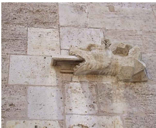
Imagen 63 DRAGÓN. Imposta en la fachada oeste, en el encuentro no aparejado de los bloques de piedra, entre el cuerpo del consulado del mar a la izquierda y el torreón a la derecha.
