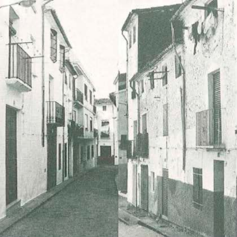
8.2.1.B. 8 Vista de una calle de Pegu y una calle de Concentaina, Alicante.
