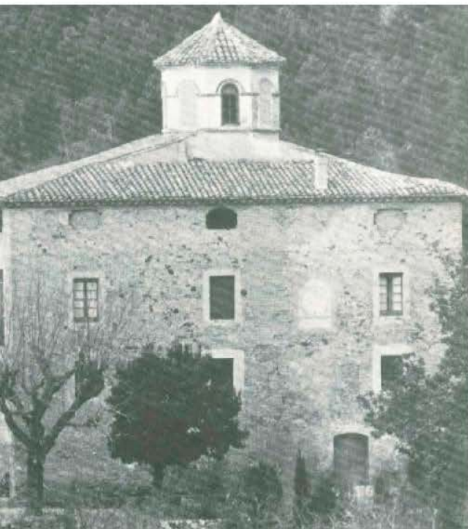
8.2.1.C. 11 Vista de Masía perteneciente al grupo III según la clasificación del arquitecto Josep Danés y Torras. Cabassers, Tarragona.
