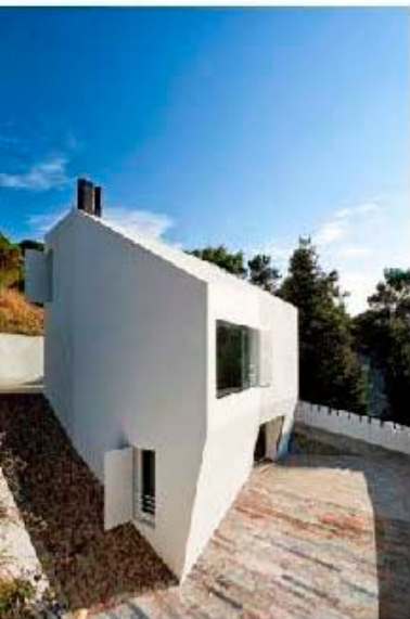
10.4.24 Casa Ylab, Barcelona (2014) YLAB Arquitectos
