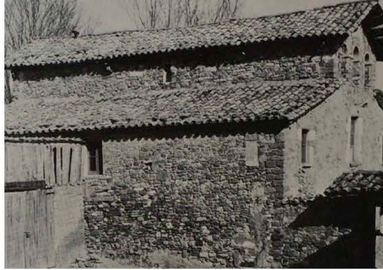
8.2.1.C. 10 Vista de masía basilical "Corminons de la Creu". Tona, Barcelona.
