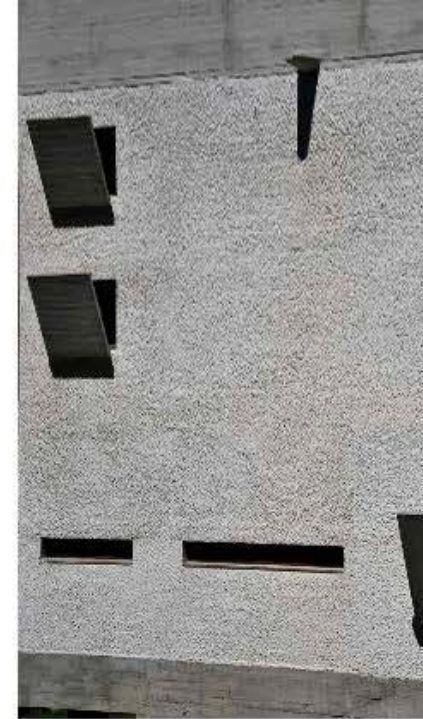
7.4. 2 Convento de la Tourette, Lyon, Francia (1957-1960) Le Corbusier
