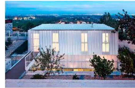
10.4.65 Seasonless House Vinaròs, Castellón (2013) Irene Castrillo Carreira y Mauro Gil-Fournier Esquerra Arquitectos
