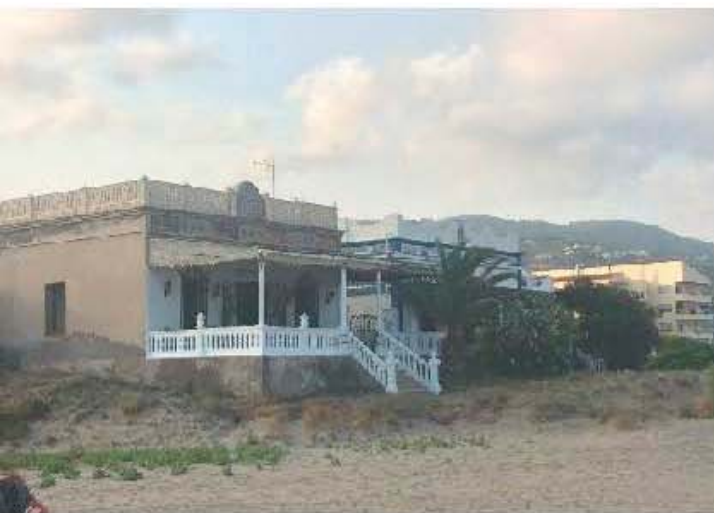
B.2.1.B. 24 Vivienda rural en Alcocebre, Castellón
