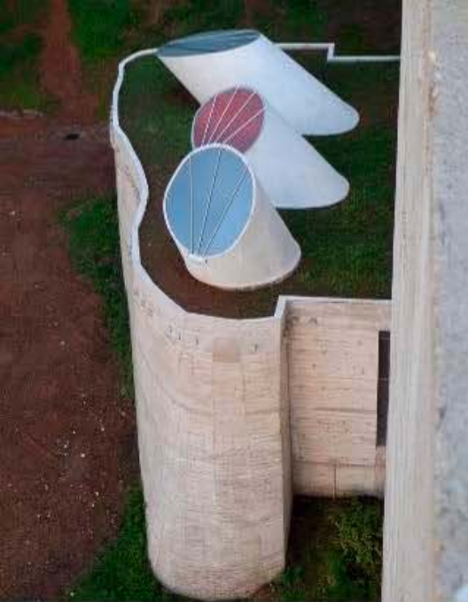
7.1. 3 Convento de la Tourette. Lyon, Francia (1957-1960) Le Corbusier
