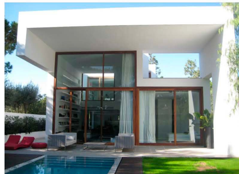
10.3. 15 Vista del salón y porche desde el exterior. Vivienda en Rocafort.
