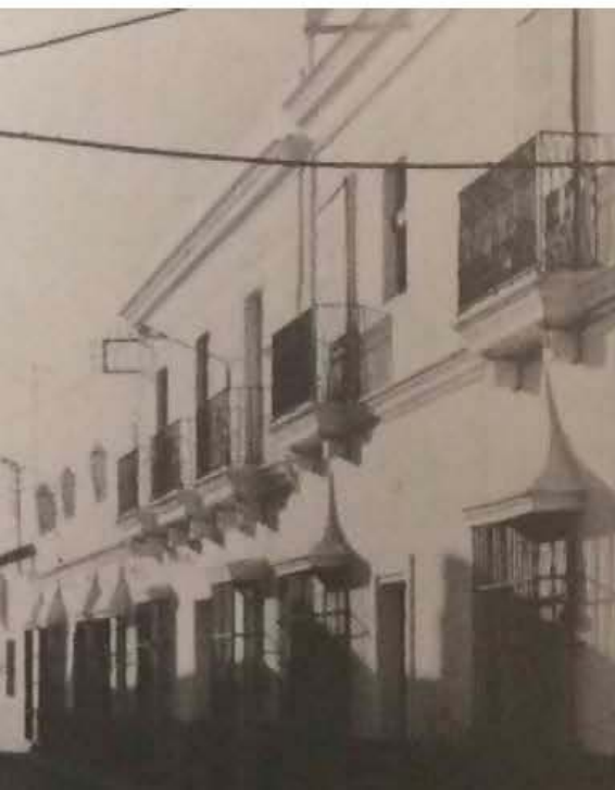
B.2.1.A. 20 Vista de calle con viviendas populares, Chipiona, Cádiz.
