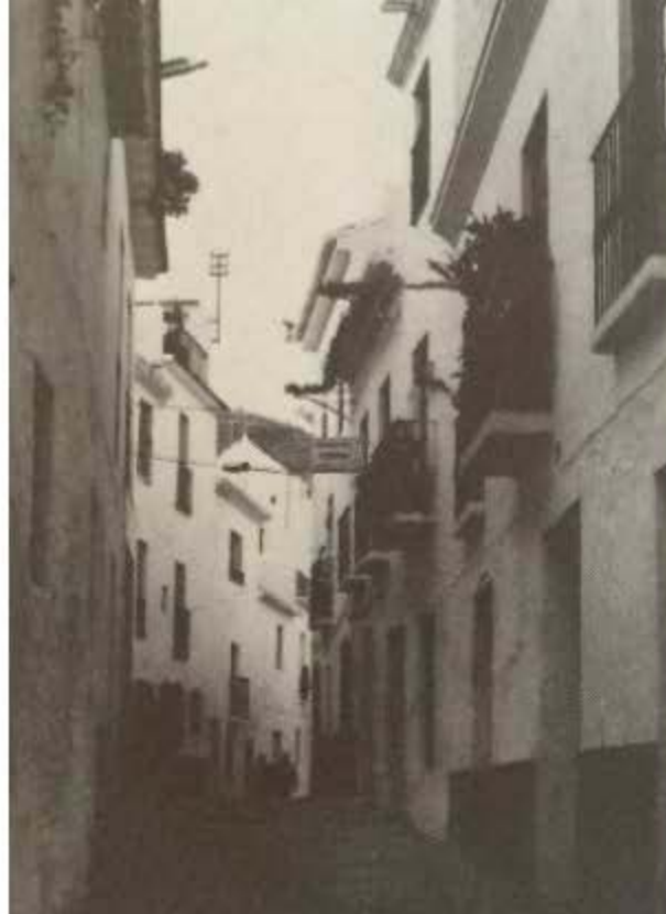
8.2.1.A. 8 Vistas de dos calles de la población de Torrox. Málaga.
