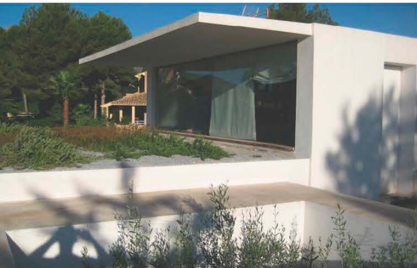
10.3. 1 Estudio y cubierta ajardinada de la Casa Escudero.
