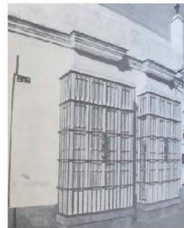
B.2.1.A. 22 Vista de viviendas tradicionales en San Fernando, Cádiz.
