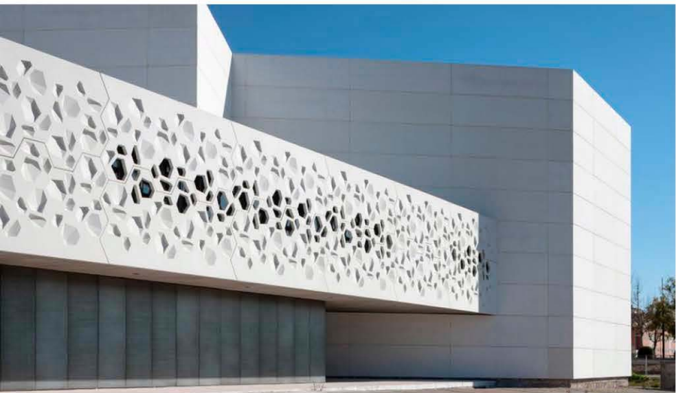
7.3.1. 8 Centro de Creación Contemporánea de Andalucía, Córdoba (2005-2013) Nieto y Sobejano
