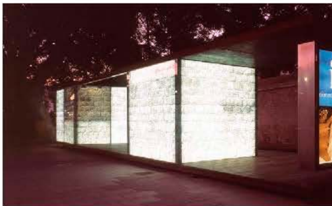
7.7.12 Cabina de información turística. Cartagena (2002) Martín Lejarraga Piel traslúcida de vidrios laminados 6+6 serigrafiados
