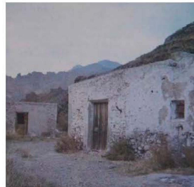
10.4.4 Vista de vivienda cúbica murciana. Mazarrón, Murcia.
