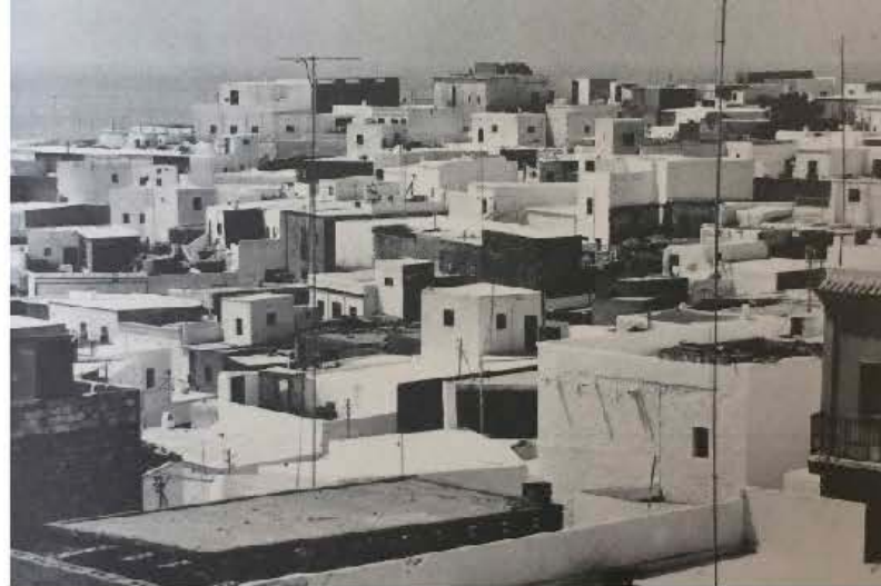
B.2.1.A. 18 Vista de la población de Adra, Almería
