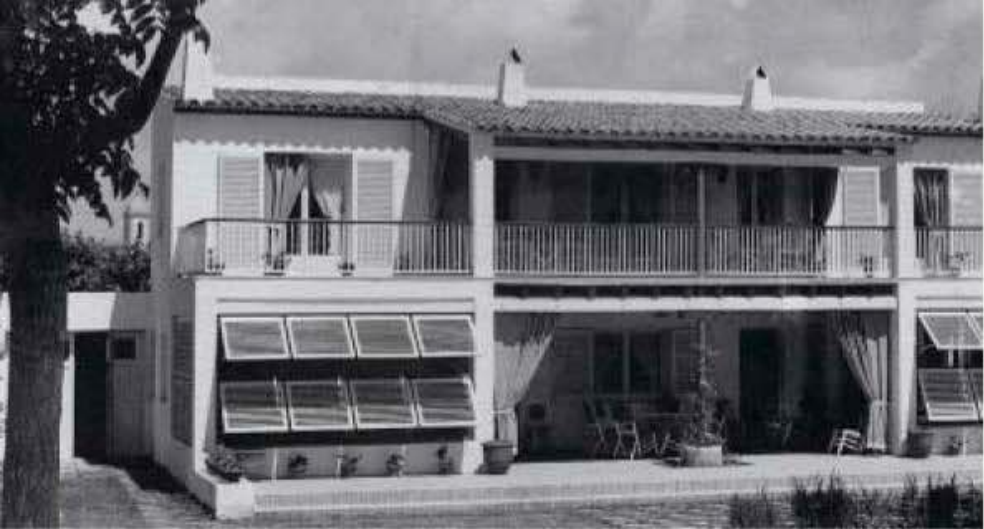
7.9. 4 Vista de fachada desde el patio de la Casa Garriga Nogués. Sitges, Barcelona (1947) J.A. Coderch Persianas de librillo de lamas fijas, pivotantes con eje horizontal
