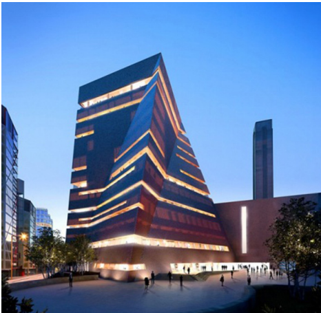
Fig.3.58. Ampliación de la Tate Modern, actualmente en construcción.
