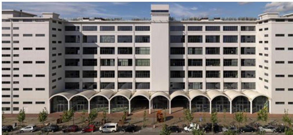
Fig.3.145. Vista de la fachada del edificio Gerard desde la calle Toneralle, Jo Coenen,2013.
