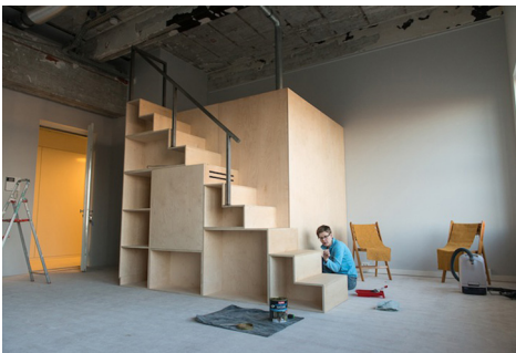
Fig.3.148. Bloque sanitario de una de las viviendas tipo loft del edificio Gerard. El módulo, además de albergar el uso de aseo cuenta con una escalera, cuya parte inferior sirve de almacenaje, que permite acceder al “desván”.
