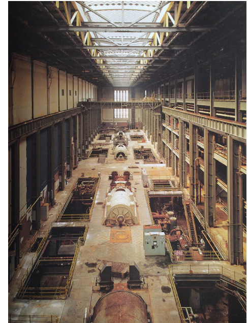
Fig.3.152. El sobredimensionamiento puede apreciar en la sala de turbinas de la Bankside Power Station, en 1994, antes de eliminar el forjado y la maquinaria.
