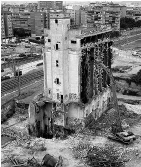
Fig.3.16. Demolición de los silos de San Blas, 2011.
