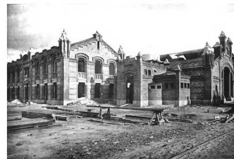
Fig.3.102. Laboratorio general para reconocimiento de carnes y jamones, en fase de construcción.
