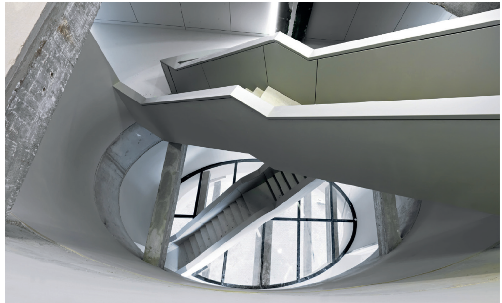
Fig.3.144. Uno de los cinco núcleos cilíndricos creados para albergar los elementos de comunicación vertical.
