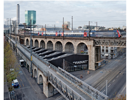
Fig.3.24. Restauración del viaducto de Letten, Zurich, EM2N, 2008-2010.
