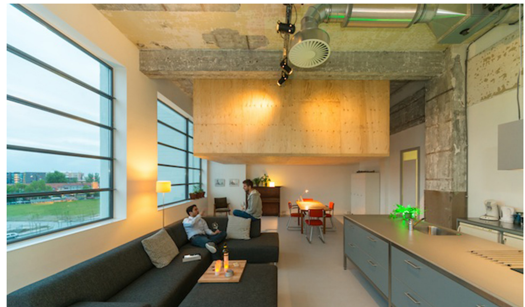
Fig.3.148. Bloque sanitario de una de las viviendas tipo loft del edificio Gerard. El módulo, además de albergar el uso de aseo cuenta con una escalera, cuya parte inferior sirve de almacenaje, que permite acceder al “desván”.
