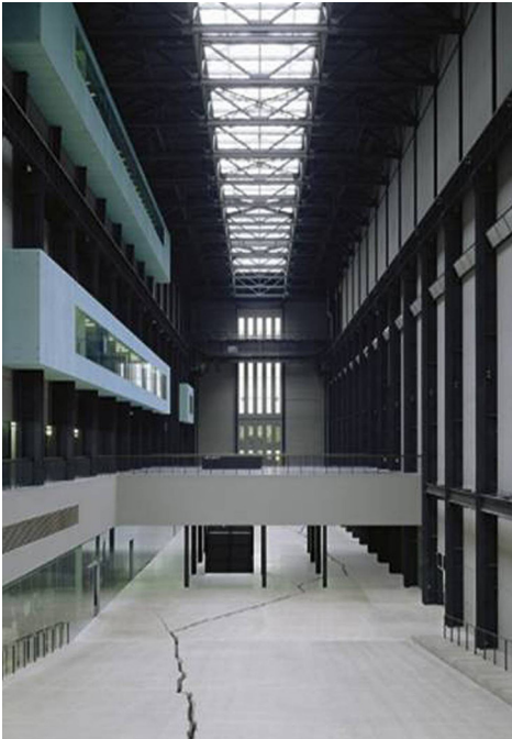
Fig.3.52. Sala de turbinas y miradores.
