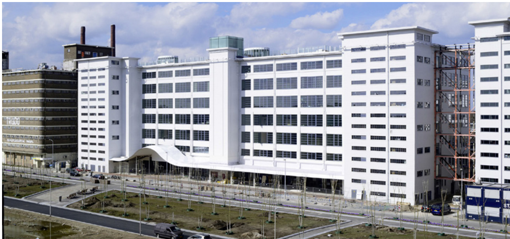
Fig.3.140. Vista de la fachada del edificio Anton desde la calle Toneralle, Diederendirix Architects, 2013.
