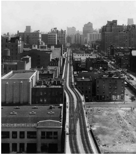
Fig.3.71. El soporte, estado original del High Line.
