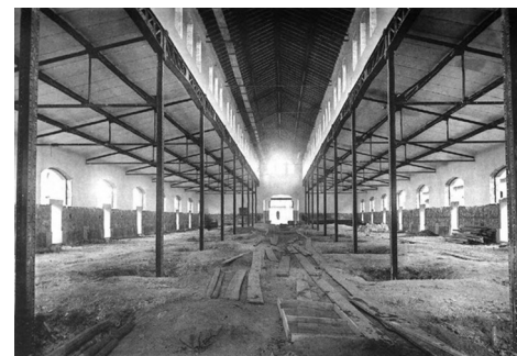
Fig.3.103. Una de las dos naves de degüello de ganado vacuno, en fase de construcción.
