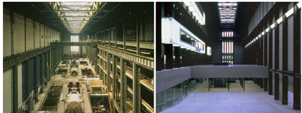
Fig.3.43. La sala de turbinas, antes y después de la intervención.
