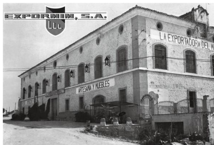
Fig. 21. Fachada. Fuente: Archivo fotográfico Expormim.
