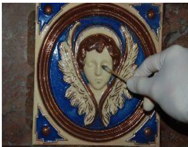
Ilustración 7: Limpieza de las cerámicas de los techos del Oratorio Fuente: Palau Ducal dels Borja
