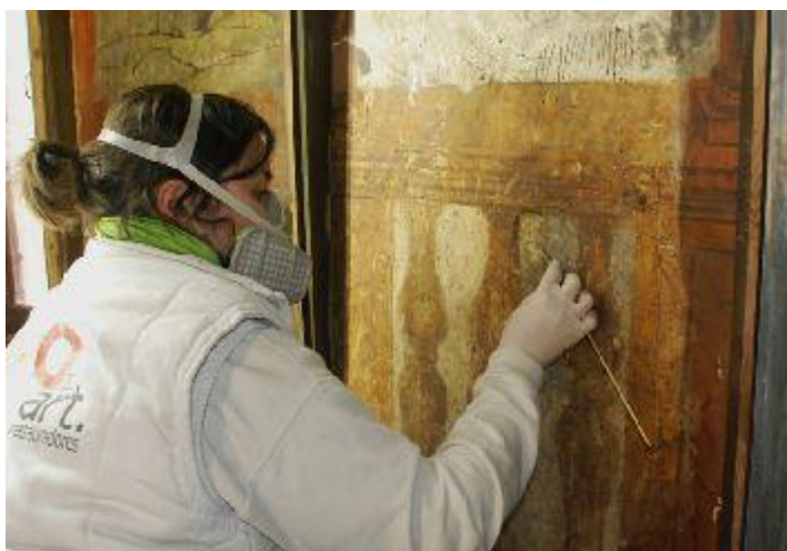
Ilustración 6: Labores de limpieza química de las grisallas del Oratorio Fuente: Palau Ducal dels Borja
