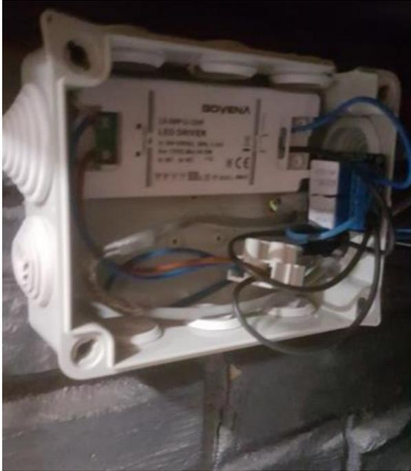
Aquí tenemos centralizada lo que sería la parte de potencia, donde tenemos la fuente de alimentación de 24v , para alimentar el rele de la electroválvula ya que esta funciona a 24 v en cc.
