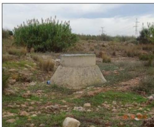
*Figura N° 11.4 Infraestructura de concreto, caja de válvulas*
